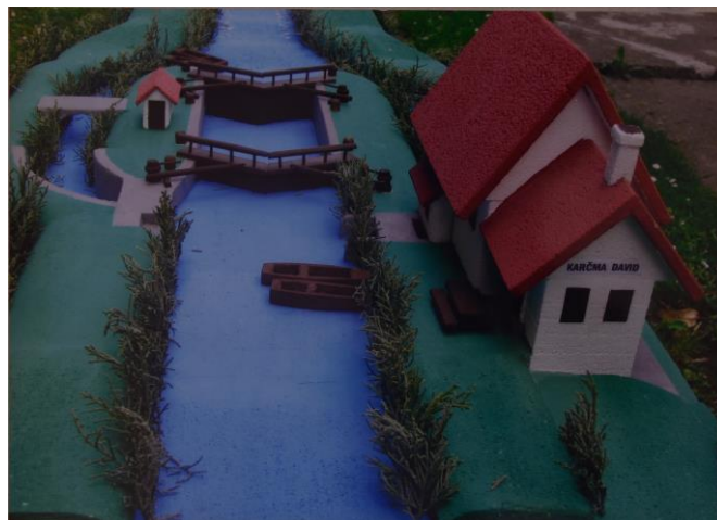
Сл. 159 Макета преводнице са клинкетом и млином поред ње
