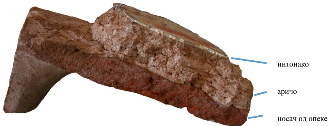
Сл. 14. Носач од опеке са слојевима малтера.
