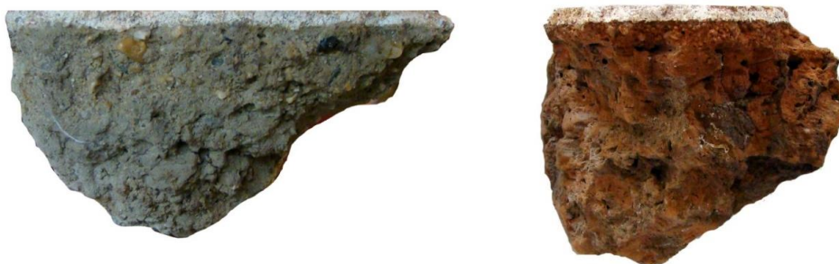
Изглед малтера фрагмената из укопа објекта 22.
