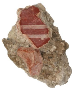
Сл.8. уломци керамике у слоју за изравнавање зида, тзв. кочопесто.
