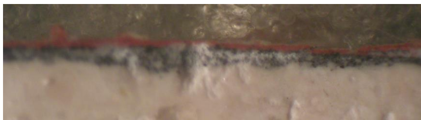
Црвена боја на подслику црне, на белом интонаку
