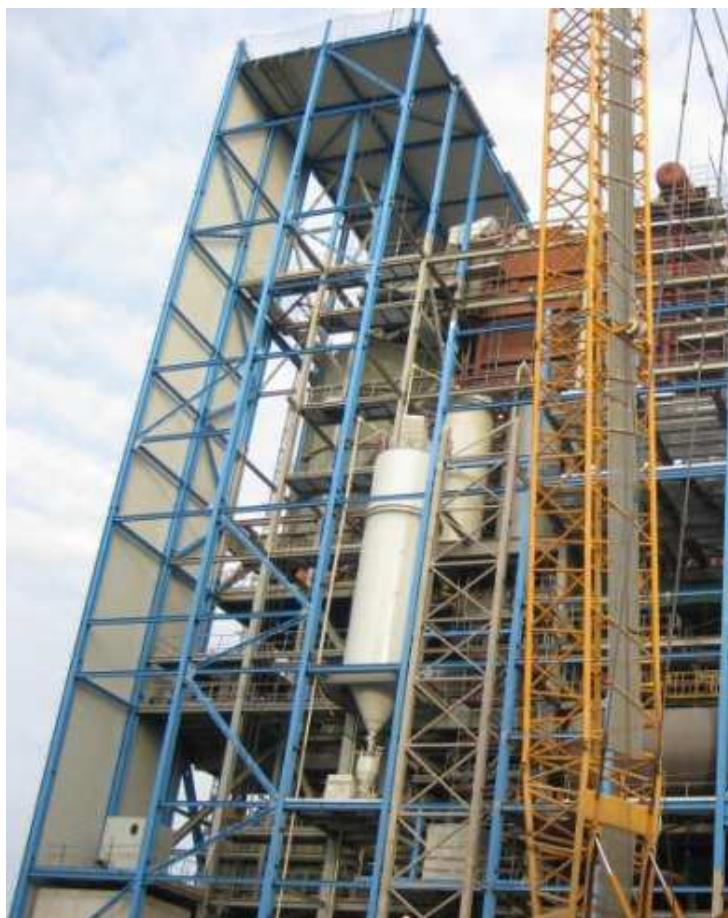
Слика 1.1. Монтажа котла [9]
