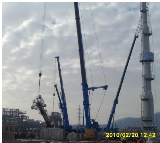
Слика 5. 1 Монтажа бакље у рафинерији[124]
