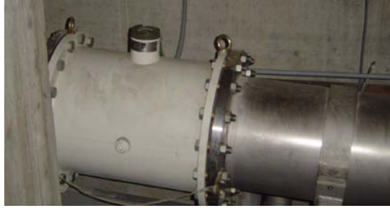
Слика 3.8. Електромагнетни протокомер
