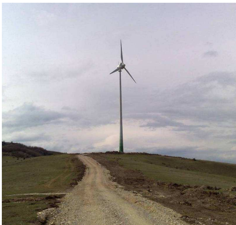
Slika 5.19: Prvi vetroagregat izgrađen u Srbiji (Enercon E40, 500 kW, H=63 m) na lokaciji u blizini sela Leskova. Mikrolokacija i procena proizvodnje je urađena na osnovu metodologije prezentovane u ovom radu
