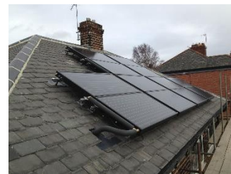
Слика 2.5 – Хибридни соларни пријемник [20]
