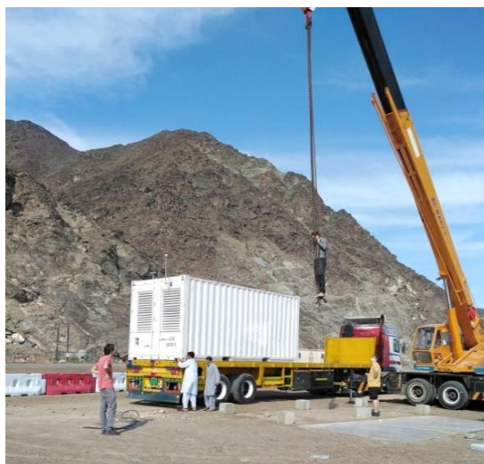
Slika 4.18 Prevoz i instalacija Tx kontejnera bistatičkog radara
