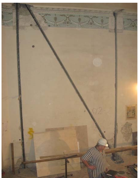
Сл. 94 Вертикално укрућење са дампером у дну дијагонале и Сл. 95 Детаљ сидрења у нивоу подрума
