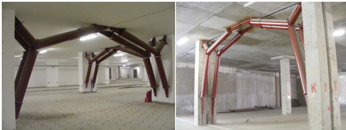
Сл. 96 Вертикално укрућење са дамперима у подруму и Сл. 97 Вертикално укрућење са дамперима на спрату.
