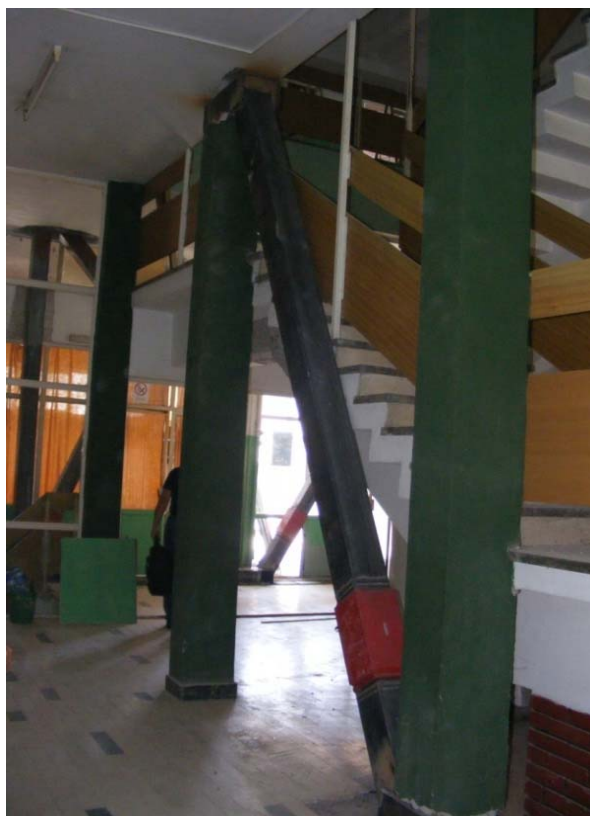
Сл. 110 Вертикално укрућење скелетног бетонског систем са новим вертикалама.
