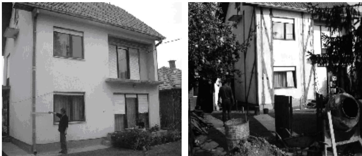
Сл. 82 Кућа пре (лево) и после (десно) појачања Системом ДЦ 90 са дамперима
