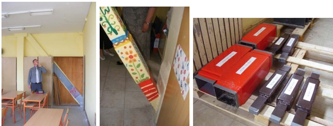
Сл. 112 Вертикално укрућење ОШ краљевачки партизани, Сл. 113. Дампер обојен на часу ликовног васпитања и различити типови дампера. Force in damper \pm 1100 kN, displacement \pm 5 mm. (and solid cross-section 50x80 mm.)
