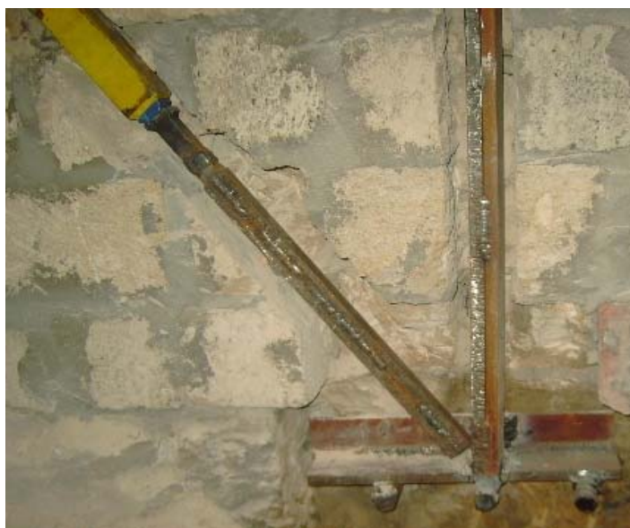
Сл. 94 Вертикално укрућење са дампером у дну дијагонале и Сл. 95 Детаљ сидрења у нивоу подрума
