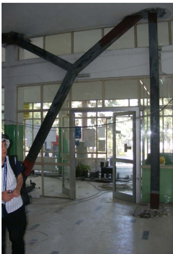
Сл. 110 Вертикално укрућење скелетног бетонског систем са новим вертикалама.
