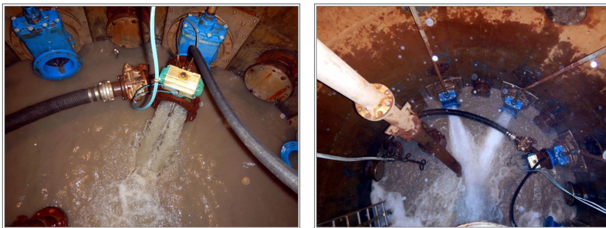
Slika 29: Izgled brzopoteznog zatvarača (levo), slobodno isticanje drenova (desno)
