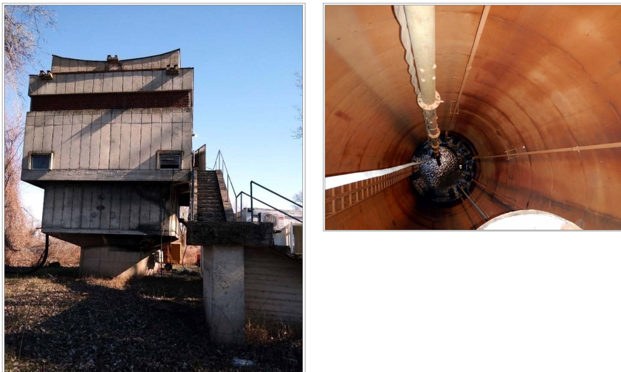
Slika 17: Izgled nadzemne konstrukcije i unutrašnjosti vodosabirnog šahta bunara RB-5m
