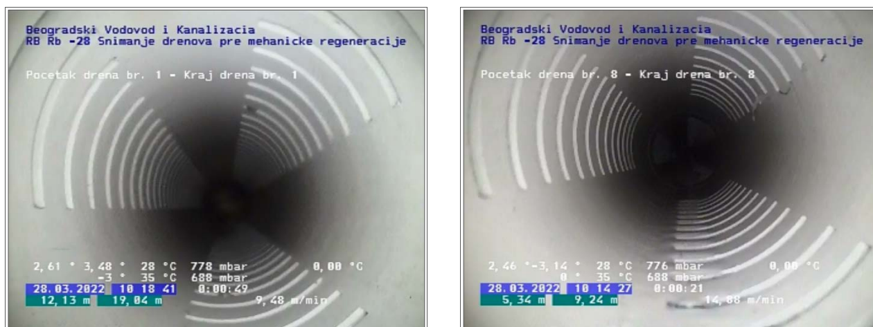
Slika 43: Izgled stanja PVC cevi u drenu 1 i drenu 8 (napomena: oba drena su u potpunosti suva pri slobodnom isticanju u bunarski šaht)
