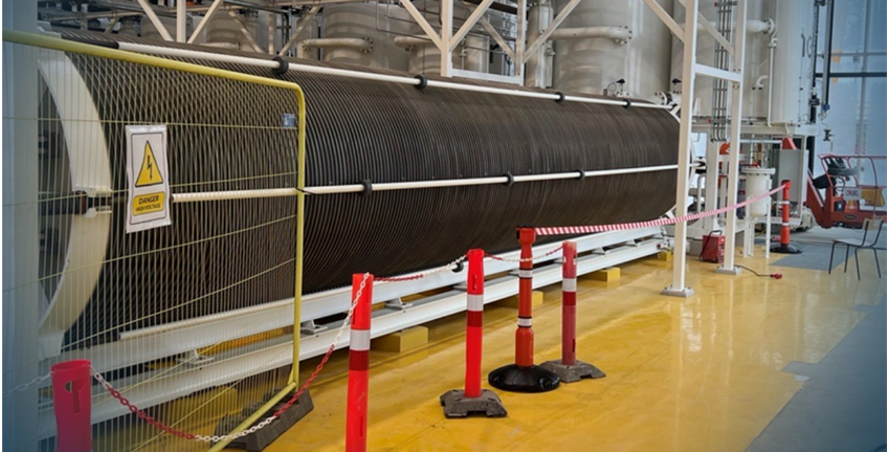
Slika 2.11. Najveći elektrolizer na svetu (HySynergy, Everfuel, Danska)[72]
