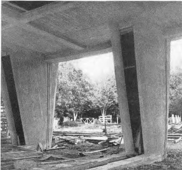
Les pilotis avec le passage de toutes les canalisations The concrete pilotis housing all service pipes
