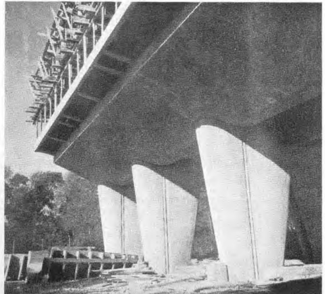
Le «sol artificiel» est relié au sol naturel par des pilotis, reposant sur des semelles en pyramides tronquées The 'artificial ground' houses the mechanical installations. It is connected to the actual ground by the pilotis, which rest on footings in the form of truncated pyramids
