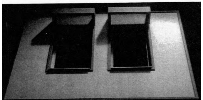
Илустрација 54 – [Милан Лојаница – а) Процес настанка одабраног ликовног решења карактеристичне фасаде урбанитета Блок 19а – мотив, генеза и контекст; б) Пренос префабриковане арматуре карактеристичних макро-фасадних елемената; в) Калуп са разупирачима прозорских рамова карактеристичних макро-фасадних елемената (недатирано)] Извор – Архива академика Милана Лојанице.
