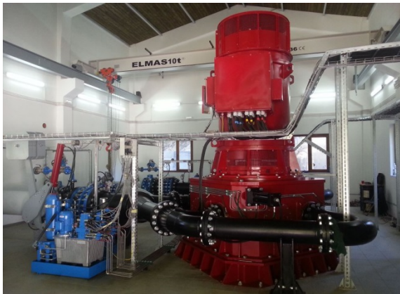
Slika 5.26. Vertikalna Pelton–ova turbina
