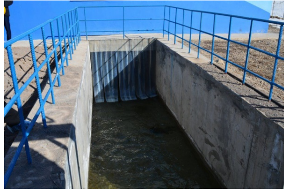
Slika 5.25. Ulaz u taložnicu
