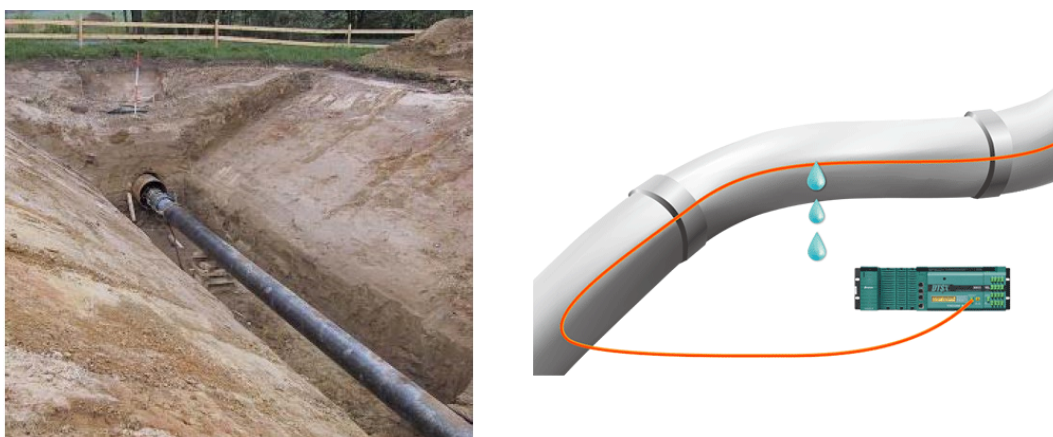
Slika 6.3. Optički kabl postavljen duž cevovoda
