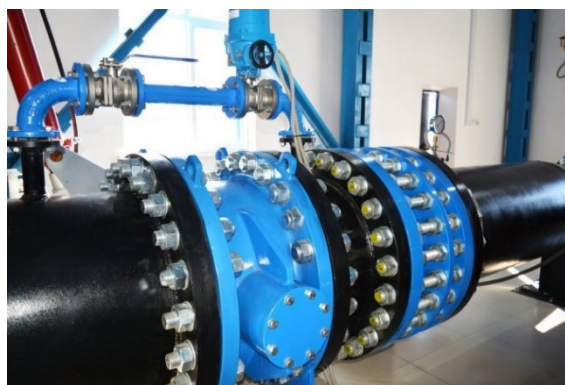
Slika 5.23. Predturbinski leptirasti zatvarač sa obilaznim vodom
