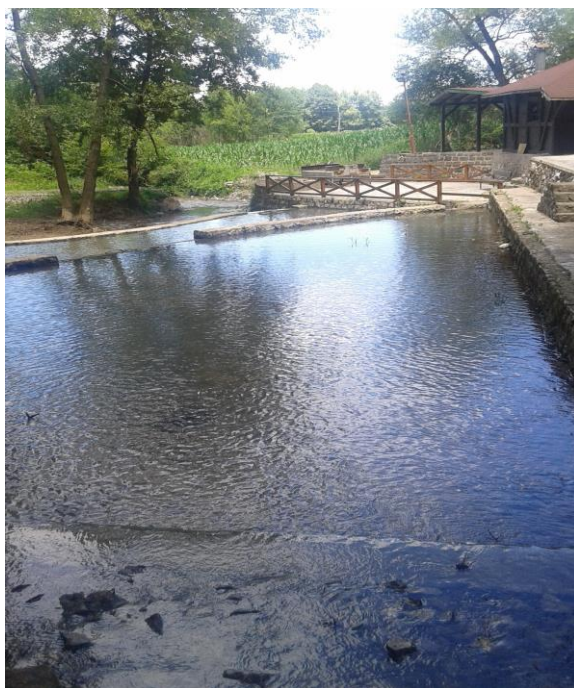
Слика 28. Хидролошки објекат врело Бање (Фото: Перић, М., 2017.)
