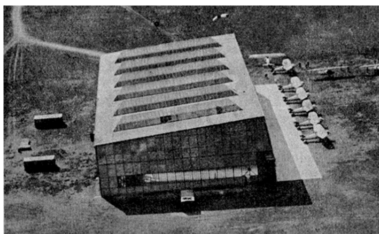
Слика 3.3.1а Хангар типа „Ц“, адреса: Дојно поље, Бежанијска Коса, конструкција произведена у Немачкој, 1927. намена: смештање и одржавање ваздухоплова, распон конструкције: 36.00 м Извор: публикувано у: Чедомир Крунић, Цивилно ваздухопловство Краљевине Југославије – прва књига, Београд, 2010, стр. 26.
