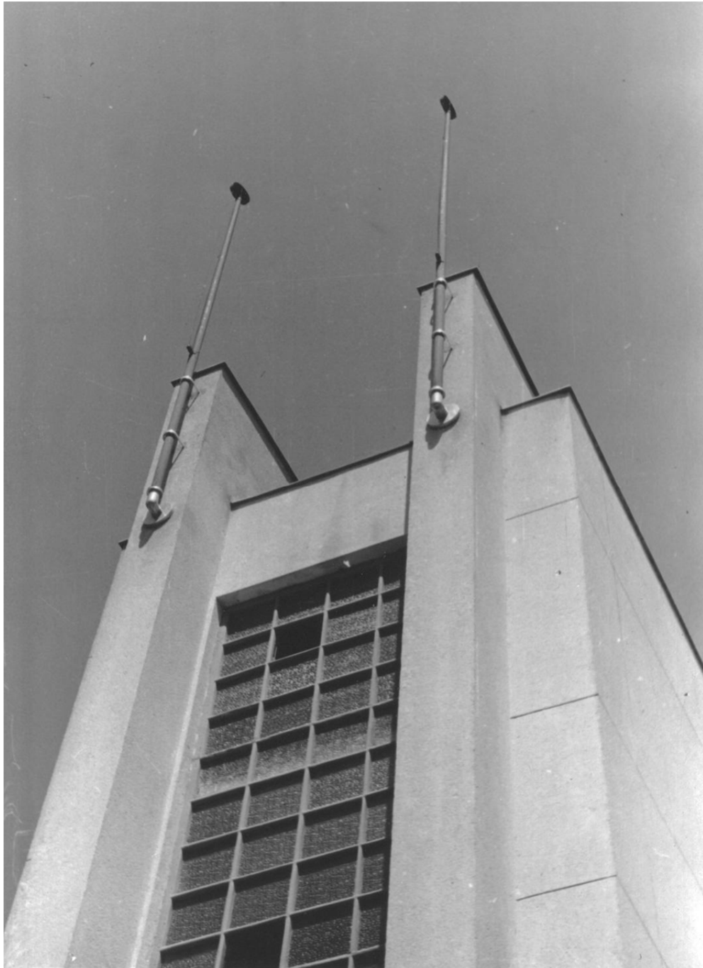
Слика 3.4.2д Државна краткоталасна радио-станица, Земун Поље, фрагмент улаза - степенишног хола / архитект: Гојко Тодић, 1937. Извор: Фотографија из приватне колекције Милоша Јуришића
