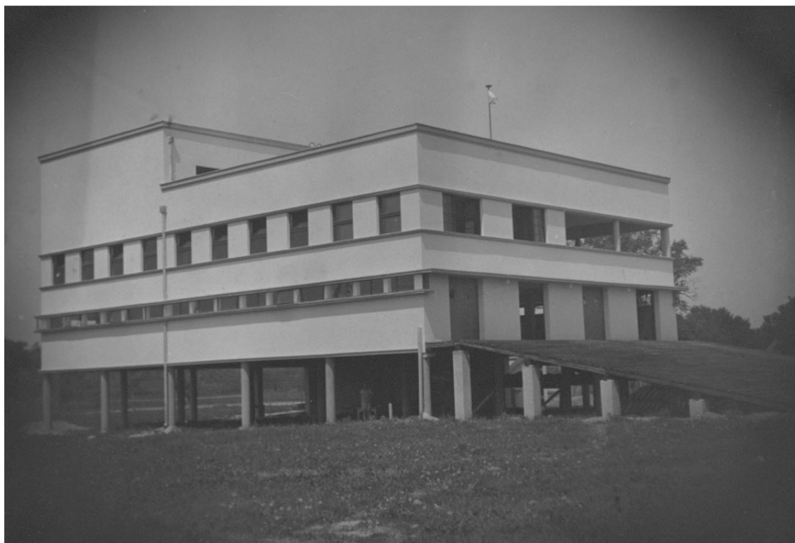
Извор: Фотографија из приватне колекције Милоша Јуришића
