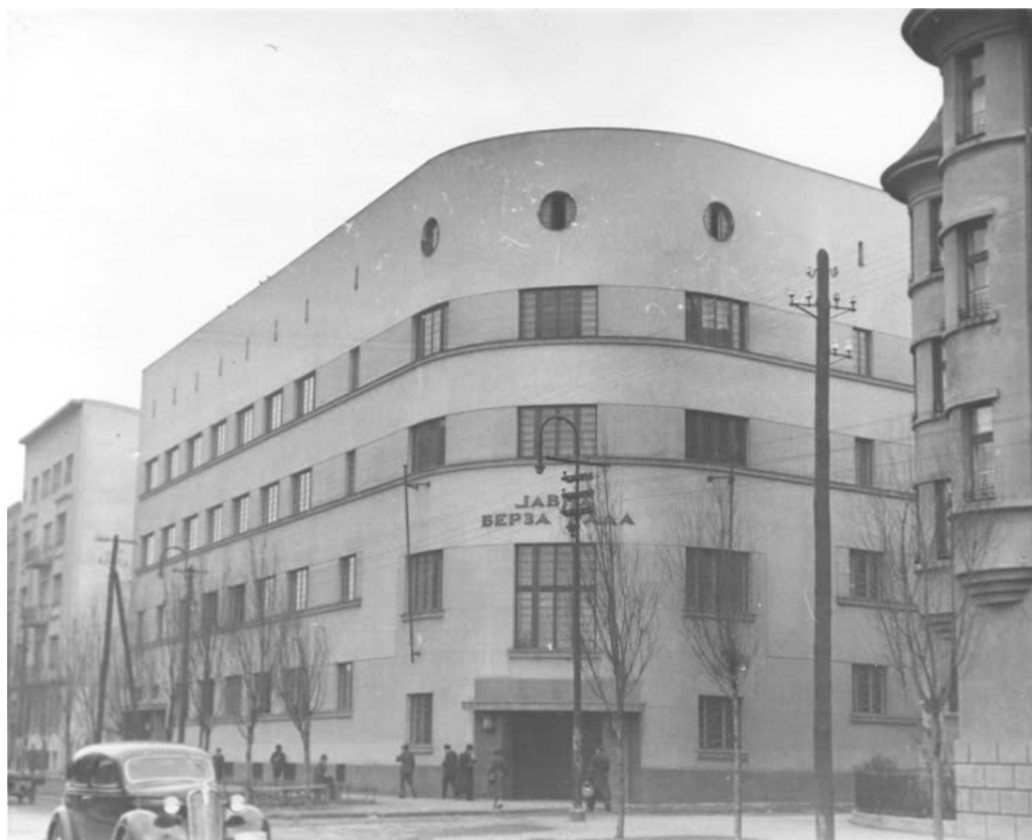
Слика 3.1.13г Зграда Јавне берзе рада, изглед из Савске улице / архитект: Димитрије М. Лeko, 1937. Извор: Фотографија из приватне колекције Милоша Јуришића
