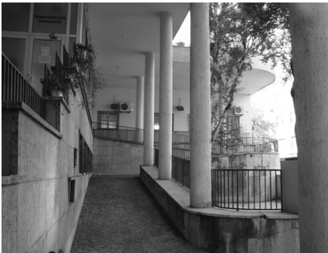
Слика 5.2.4д Универзитетска дечја клиника, детаљ улазне рампе, Тиршова улица / архитект: Милан Злоковић, 1933 / 1936-1940. Извор: фотографија ВП, септембар 2009.
