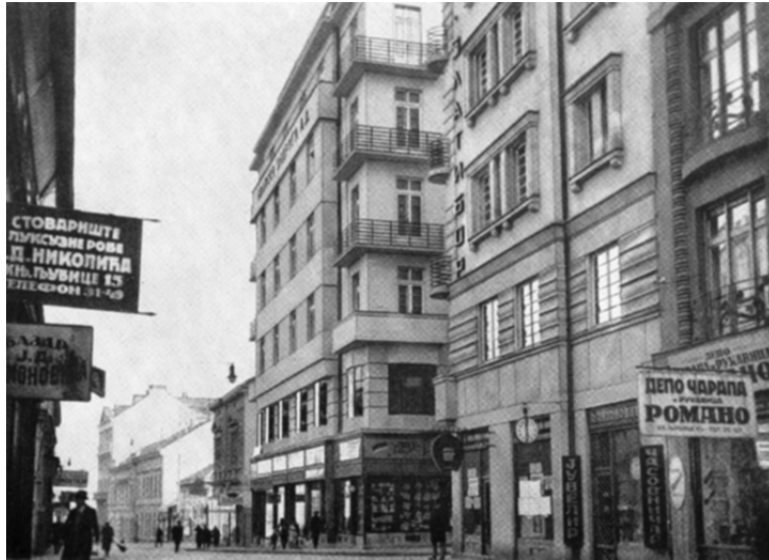
Слика 3.1.5а Банка „Златибор“, поглед из улице Кнегиње Јубице, урбанистички контекст / архитект: Ђура Борошић, 1931. Извор: Фотографија из приватне колекције Милоша Јуришића
