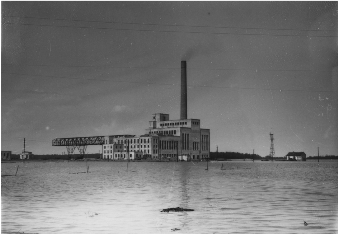
Слика 3.4.1a Стара електрана „Снага и Светлост“, Дорхол, Дунавски кеј / „Société des Banques Suisses“ и „Société Suisse d'Electricité de Traction“, Force et Lumière Базел Швајцарска, 1935. Извор: Фотографија из приватне колекције Милоша Јуришића
