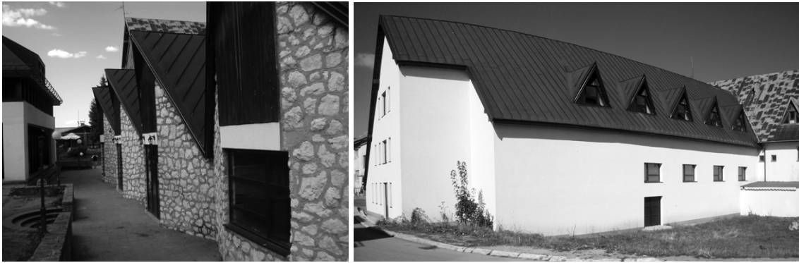
Слика 139 – Дом културе у Жабљаку – „Лице“ и „наличје“ објекта: усмјереност ка пјешачкој комуникацији и простору за сједење уз фасаду зграде Општине (лијево) и потпуна дезинтеграција са окружењем „задње“ фасаде (десно). (Извор: С. Стаматовић Вучковић)
