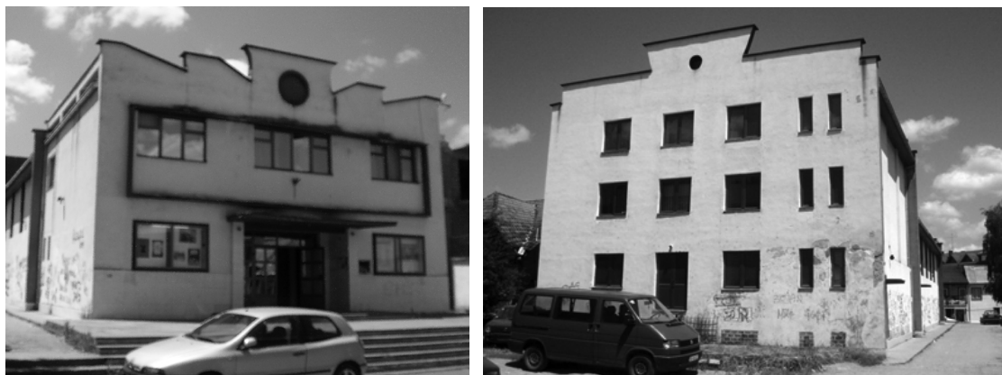
Слика 33 – Дом културе у Беранама, отворен 1961. године, предња (улазна) фасада уз улицу и задња фасада у дворишту. (Извор: С.Стаматовић Вучковић)
