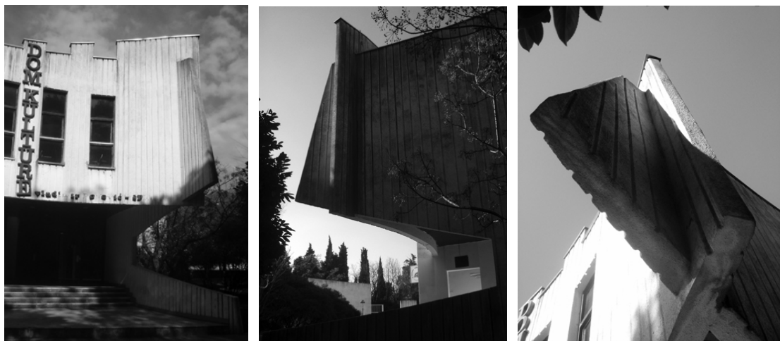
Слика 236 – Покренута, динамична армирано-бетонска платна која се „крећу“ и ван граница објекта у тежњи да успоставе контакт „унутра – споља“. (Извор: С. Стаматовић Вучковић)
