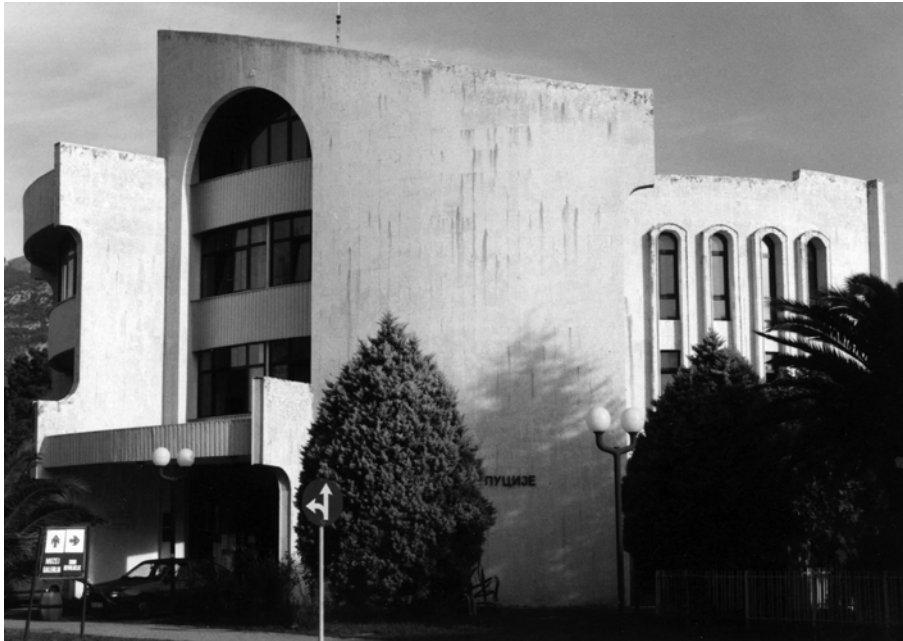
Слика 65 – Предња фасада – зидно платно у натур бетону на коме су, изнад назива „дом револуције“ били предвиђени рељефни мотиви из НОБ-а. [Извор: Радмила Милошевић]
