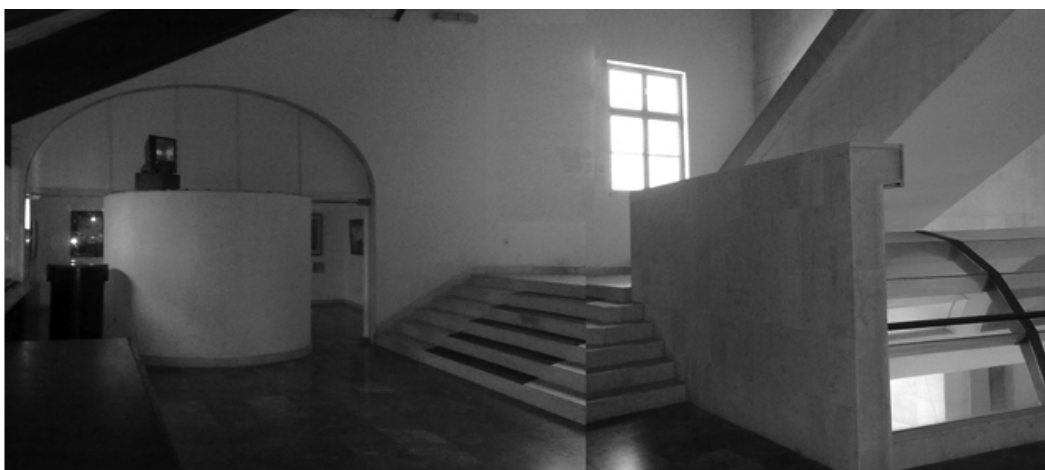
Слика 195 – Дом културе у Котору - „везни ниво“ првог спрата на коме се срећу главно степениште и степениште из галеријског простора (сакривено кружним зидом). На нивоу следеће етаже налази се главни улаз у салу. (Извор: С. Стаматовић Вучковић)
