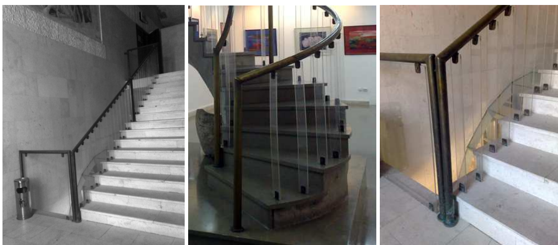
Слика 197 – Принцип транспарентности површина примијењен је и на оградама степеништа. (Извор: С. Стаматовић Вучковић)
