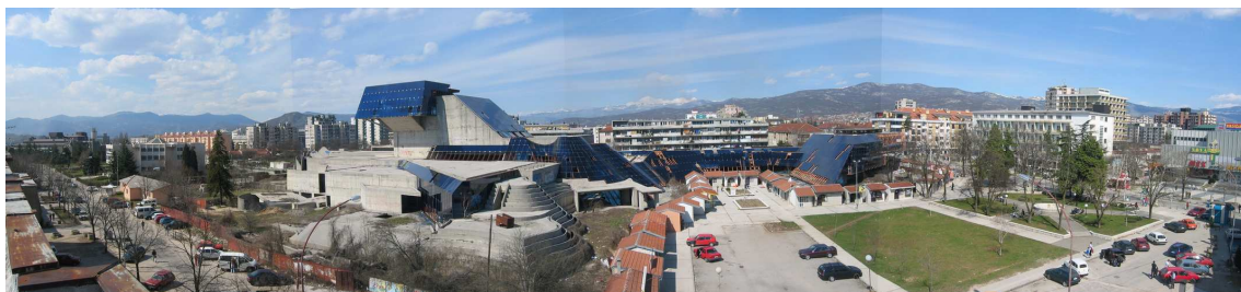
Слика 132 – Дом Револуције у Никшићу – недовршеност – трансформација – активирање идеја о „урбаној рециклажи“ – студентски рад. (Извор: Архитектонски факултет Црне Горе)
