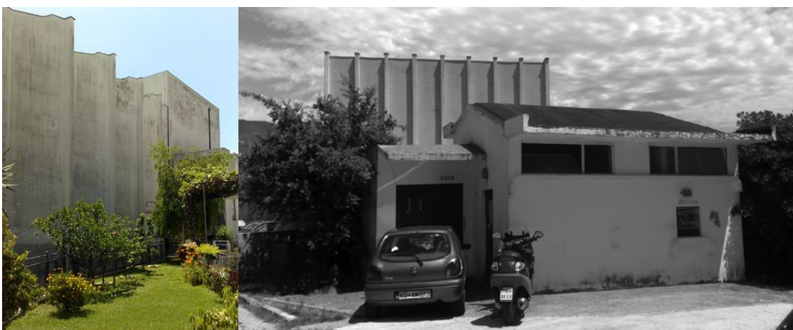
Слика 152 – Дом културе у Бијелој (1986) – бочна фасада према дворишту индивидуалног становања (лијево). Објекат билетарнице испред љетње позорнице на задњој страни објекта (десно). (Извор: С. Стаматовић Вучковић)
