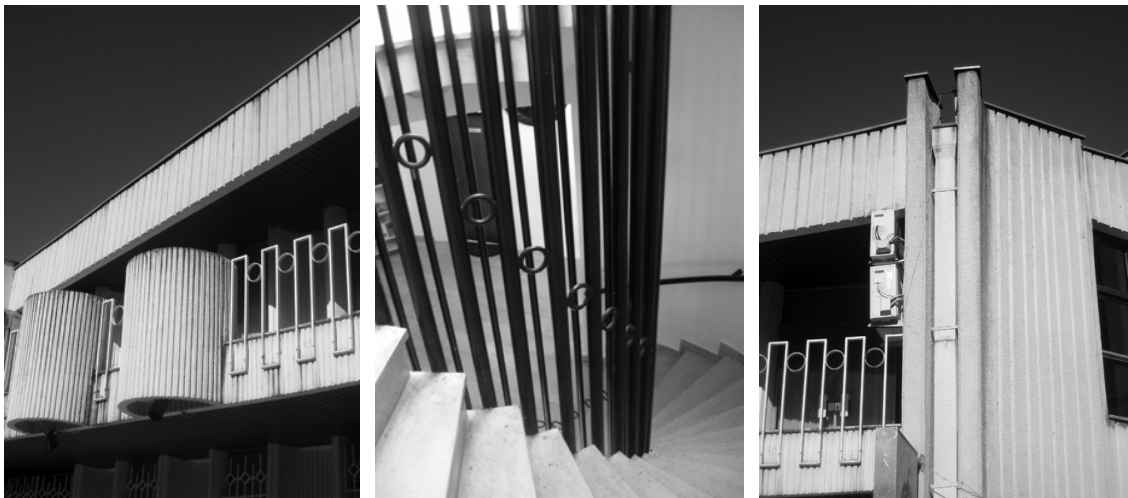
Слика 239 – Брига о архитектонском детаљу: степенишне и балконске ограде, као и вјешто скривање вертикалног олука на споју два зидна платна. (Извор: С. Стаматовић Вучковић)
