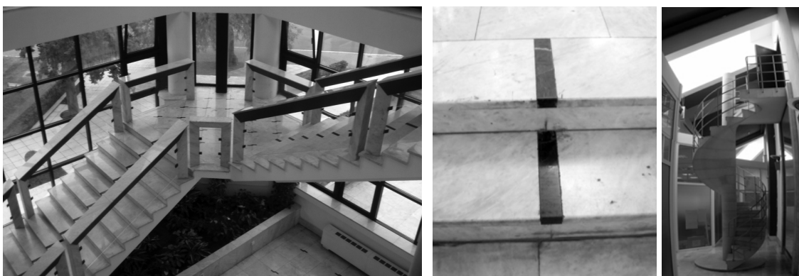
Слика 193 – Дом ЈНА у Тивту - једно од два бочна степеништа која воде до главне сале на првом спрату (лијево) са додатним маркирањем степеника – наглашено денотирање линије кретања (лијево), спирално степениште до кабине за пројекције (десно). (Извор: С. Стаматовић Вучковић)
