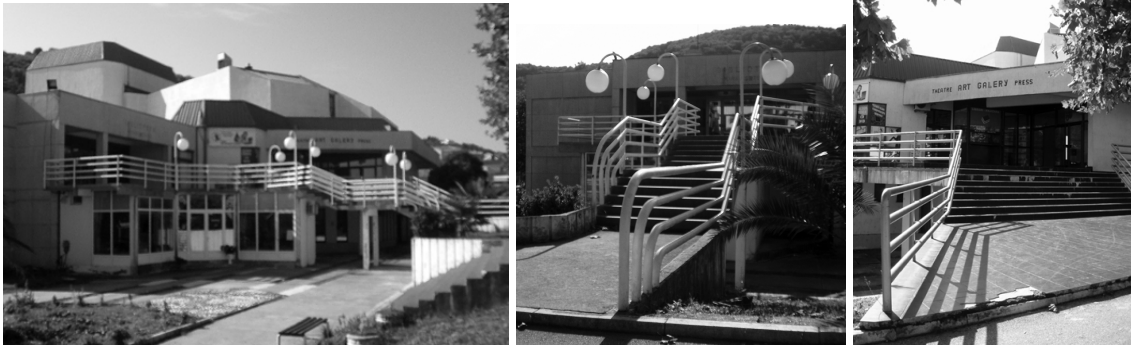
Слика 186 – Дом културе у Улцињу (1981- ). Маркирање улаза „степенишним мостовима“. (Извор: С. Стаматовић Вучковић)
