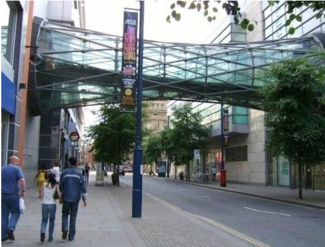
Сл.119 Пешички мост , Манчестер, Енглеска, арх. Hodder and Partners 1999. http://en.wikipedia.org/wiki/Corporation_Street_Bridge/ ,
