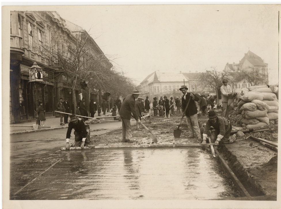
слика 8. Бетонирање и асфалтирање улице у Суботици (Архив Југославије)
