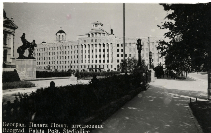
Београд. Палата Пошт. штедионице Beograd. Palata Pošt. Štedionice слика 85. Главна пошта, Београд (из колекције М. Јуришића)
