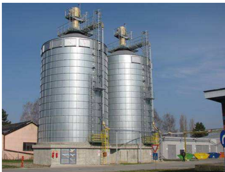
Slika 5.22 Silosi za skladištenje piljevine
