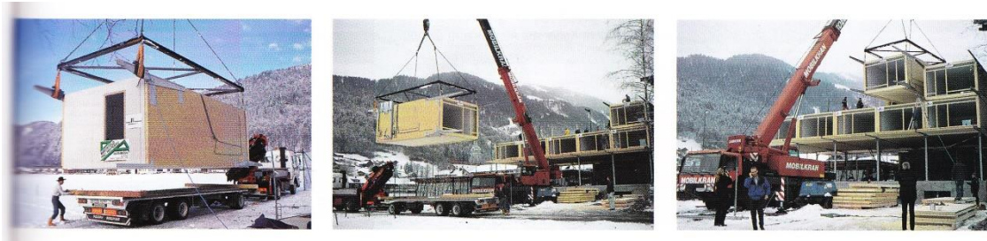
Слика 13. Изградња хотела Кроне у Ворарлбергу (Аустрија) системом модуларних ћелија (Architektur, 1999)
