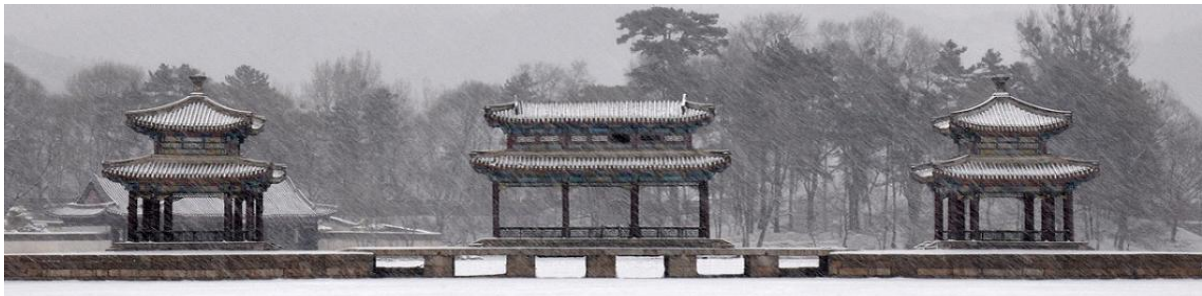
Sl. 52 Čengdu, Sje u srcu vode (shuixinxue) nad zamrznutim jezerom.
