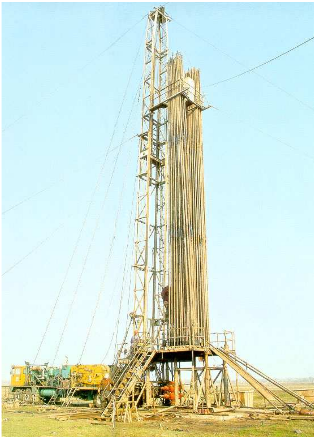
Slika 3.2. Toranj remontnog postrojenja [3.1].
