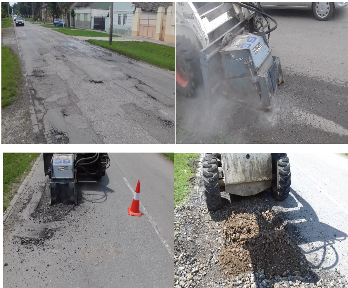
Сл. 61. Изглед постојеће коловозне конструкције и стругање и мљевање асфалта и камена
