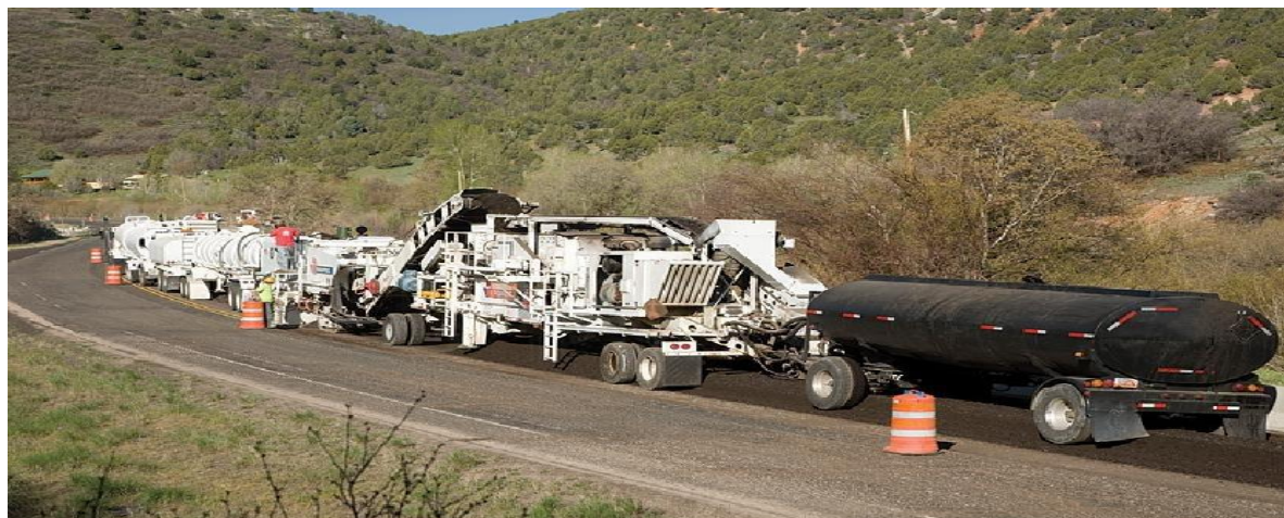
Сл. 15. Приказ рециклажног воза за хладну рециклажу на лицу мјеста [25]
