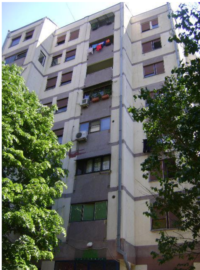
Slika 3.20.: Fotografija stambenog objekta na adresi Pasterova 10
