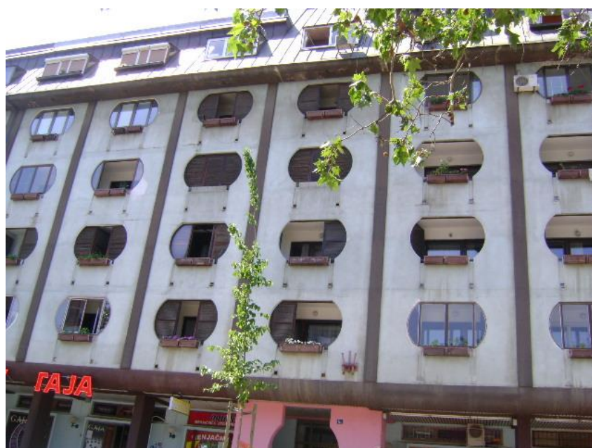
Slika 3.12.: Fotografija objekta na adresi Bulevar oslobođenja 4a
