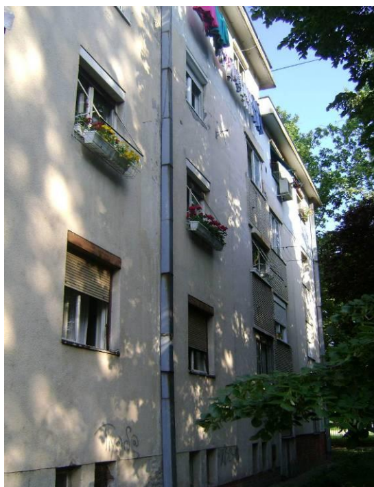
Slika 3.23.: Fotografija objekta na adresi Stevana Momčilovića 12
