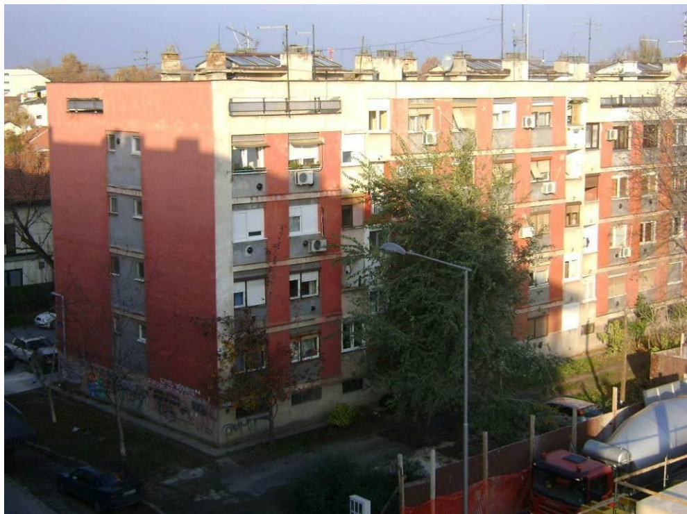
Slika 3.6.: Fotografija stambenog objekta na adresi Braće Krkljuš 7
