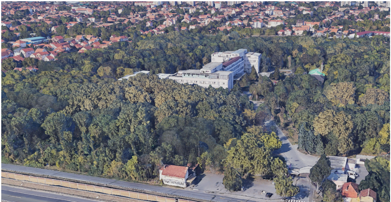
Слика 59: Просторни приказ ОПЗ и комплекса КБЦБК, извор: Google Earth
