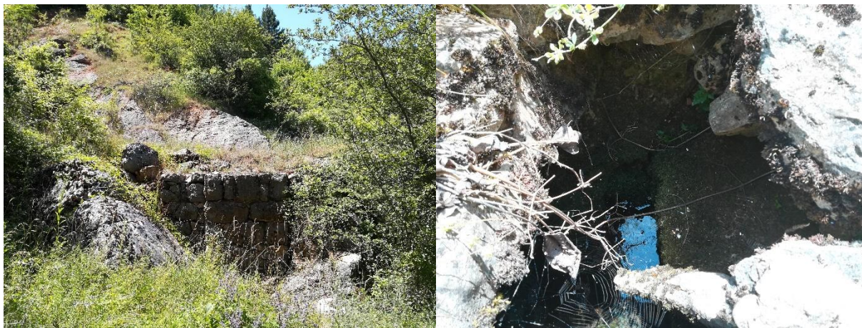
Slika 6.23. Kaptaža vrela u Bežištu
