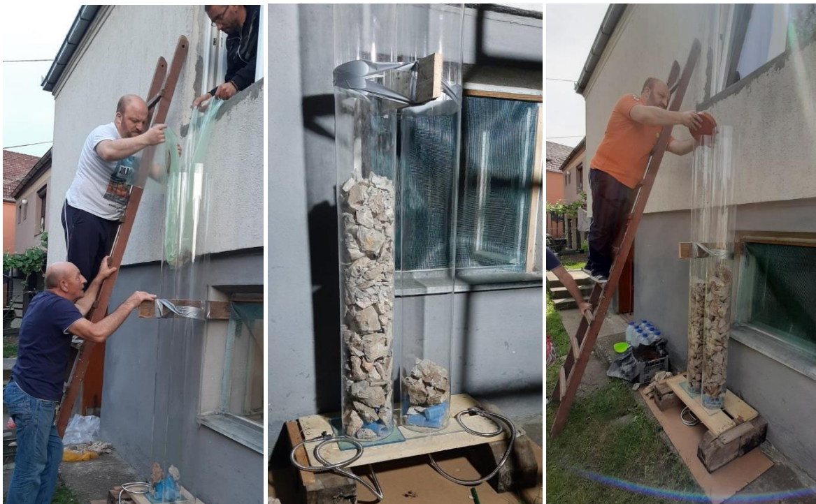
Slika 7.123. Punjenje cevi sa pripremljenim materijalom
