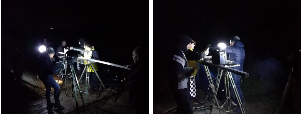
Slika 3.25 Postavljanje opreme na lokaciji Babin Potok
