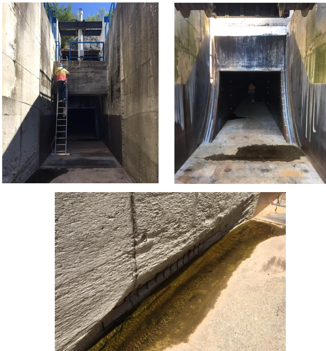
Slika 6.7 Izlazna građevina derivacionog tunela Fatničko polje – Bilećka akumulacija: Gore levo) Pogled iz brzotoka na zatvaračnicu; Gore desno) Pogled na suženi izlaz iz tunela; Dole) Oštećenje zida brzotoka usled pojave kavitacije.
