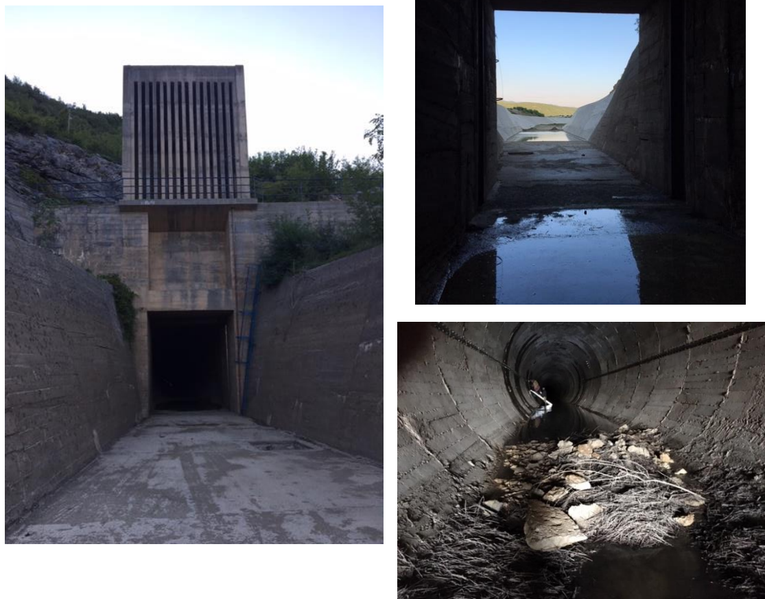
Slika 6.3 Izlazna građevina derivacionog tunela Dabarsko polje – Fatničko polje: (Levo) Pogled iz odvodnog kanala u Fatničkom polju; (Gore desno) Pogled iz tunela na odvodni kanal; (Dole desno) Zadržavanje vučenog nanosa neposredno uzvodno od izlazne građevine.
