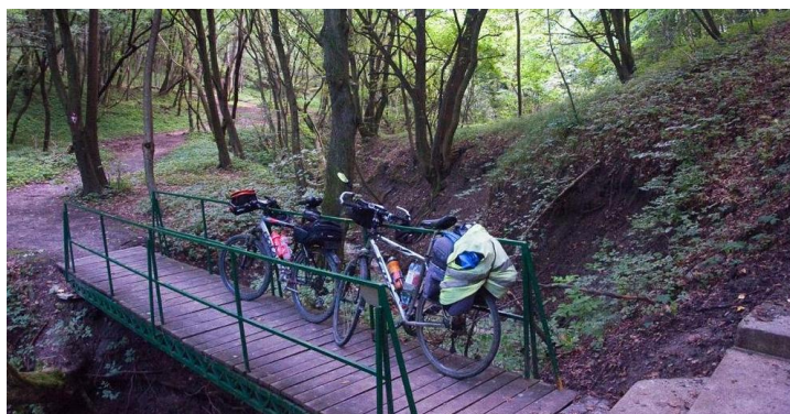
Слика 20. Мост код извора Ст. Хопово (Фото: А. Вујко, 2009)
