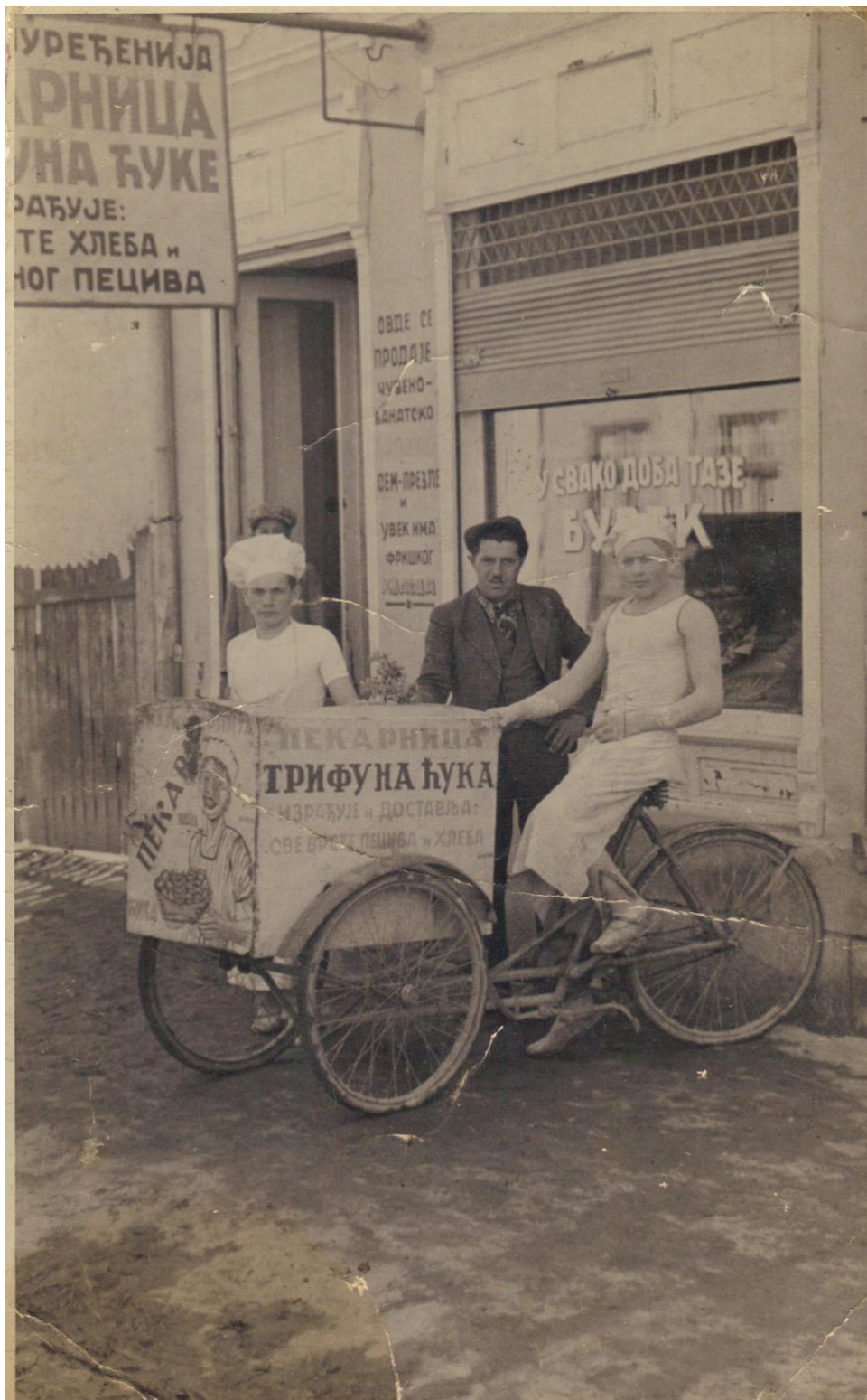
Sl. 45. Novo-otvorena pekarska radnja i prodavnica hleba Trifuna Ćuka
