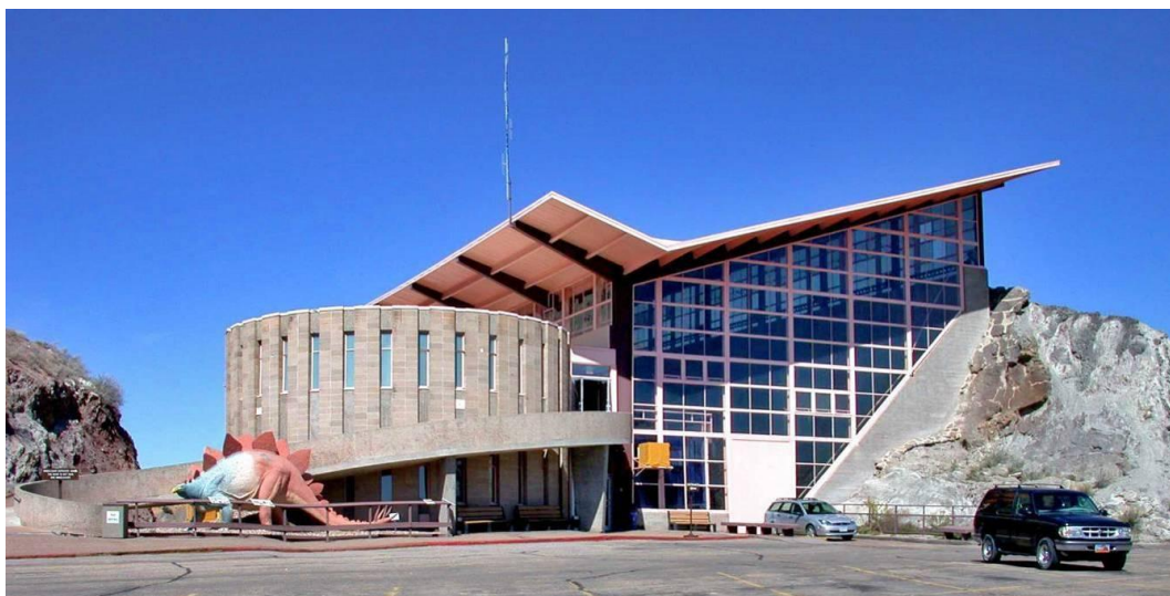
Slika 5. Vizitorski/istraživački/izložbeni centar u Fosilnom kamenolomu ( Fossil Quarry site at Dinosaur National Monument ) u Juti, u SAD (Izvor: www.nps.gov )
