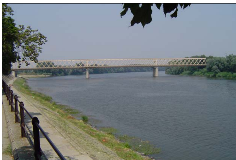
Slika 52. Tisa nizvodno od senćanskog mosta na km 123+500 (foto: D. Pavić, 2004)
