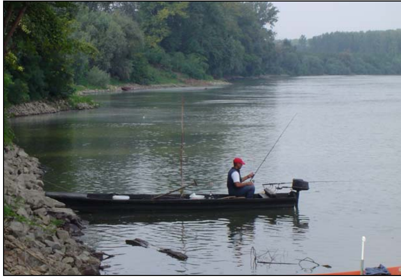
Slika 17. Obaloutvrda od lomljenog kamena (levo) duž desne obale Tise na km 22 (foto: D. Pavić, 2004)
