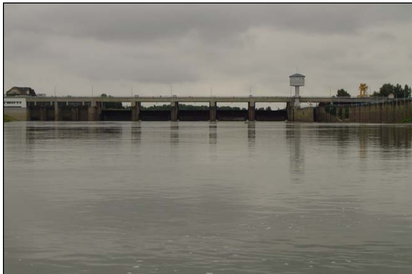
Slika 16. Betonska brana sa broskom prevodnicom (desno) i hidroelektranom (levo) na Tisi kod Kiškerea na km 404 - nizvodno (foto: D. Pavić, 2004)
