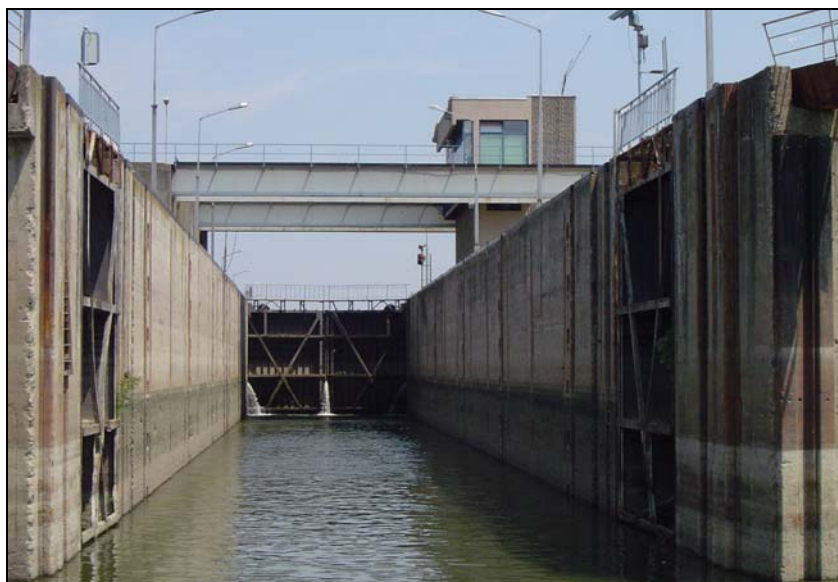
Slika 25. Brodska prevodnica u okviru brane kod Novog Bečeja na km 63 (foto: D. Pavić, 2004)
