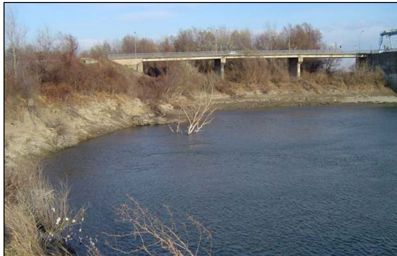
Slika 24. Zemljana pregrada - brana na Tisi kod Novog Bečeja na km 63 (foto: D. Pavić, 2005)
