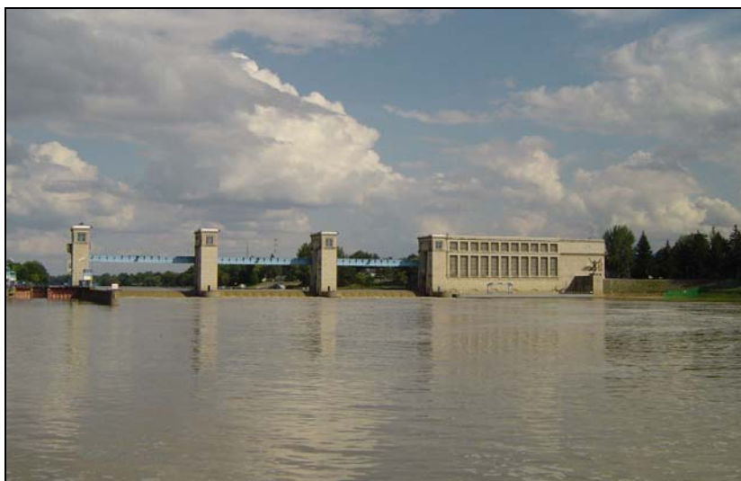
Slika 15. Betonska brana sa brodskom prevodnicom (levo) i hidroelektranom (desno) na Tisi kod Tisaleka na km 518 - nizvodno (foto: D. Pavić, 2004)
