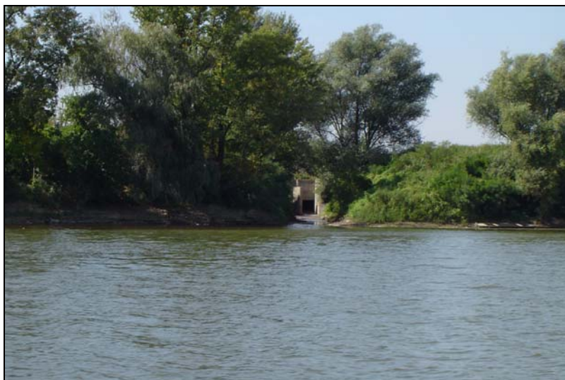
Slika 64. Ispust otpadnih voda iz Fabrike šećera Senta na km 122 toka (foto: D. Pavić, 2004)
