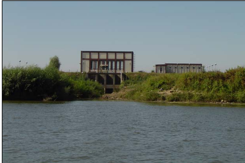
Slika 45. Vodozahvat kanala Palić - Tisa sa pumpnom stanicom na km 138 (foto: D. Pavić, 2004)
