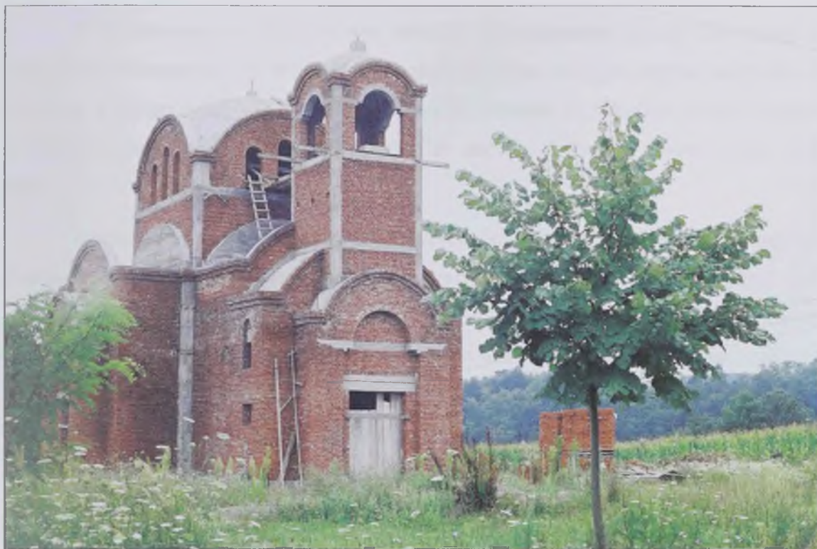
Слика 68. Вранешка црква у изградњи (Фото: Тамара Ковачевић, август 2005)
