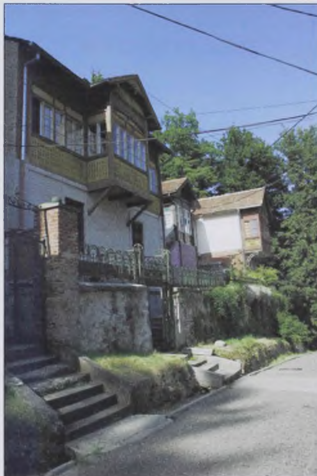
Слика 53. Примерци византијско-балканске куће на Црквеном брду у Врњачкој Бањи (Фото: Тамара Ковачевић, август 2006)
