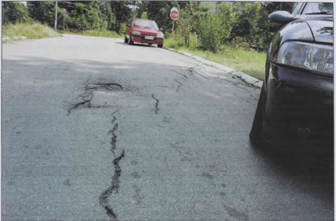
Слика 8. Зачетак клизишта на путу у близини центра Врњачке Бање (Фото: Тамара Ковачевић, август 2007)
