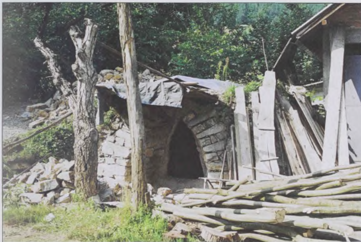
Слика 57. Пећ за печење креча у сеоском насељу Брезовица (Фото: Тамара Ковачевић, август 2005)
