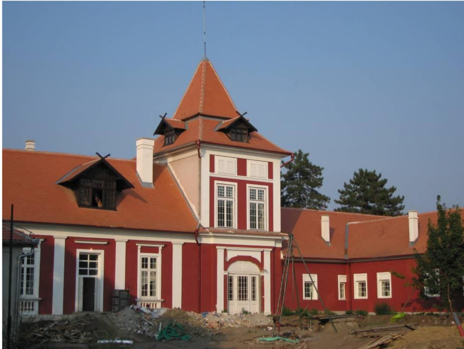
Slika 6.15. Dvorac u Ečkoj u obnavljanju (Foto: I. Mulec)
