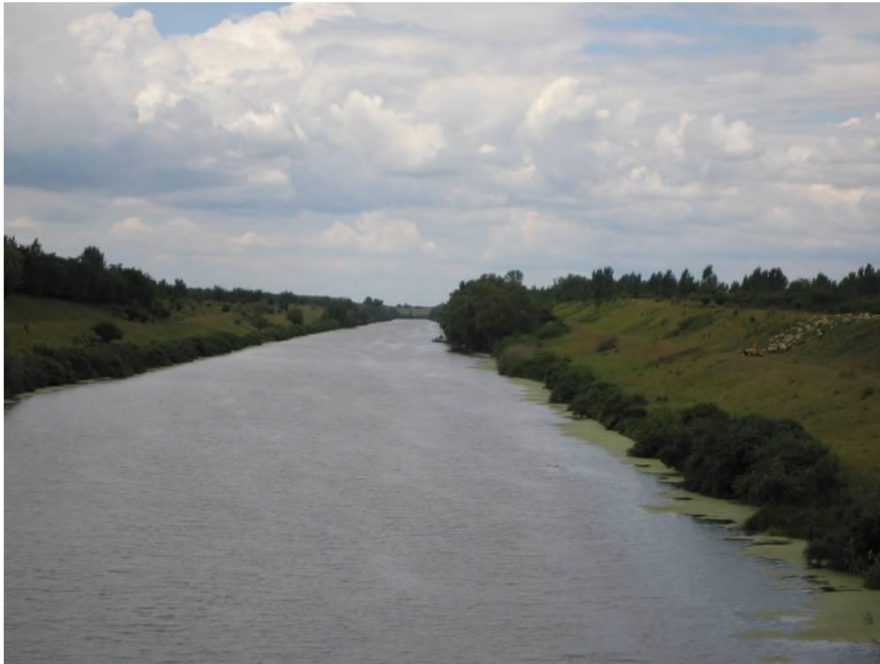
Slika 6.5. Kanal Dunav – Tisa – Dunav kod Stare Palanke (Foto: I. Mulec)
