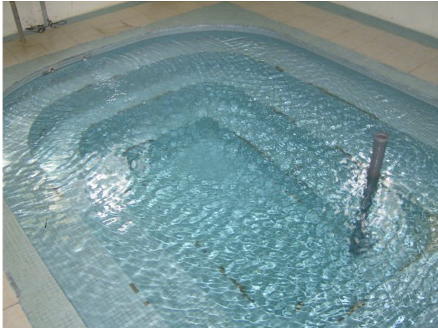
Слика 71. Део терапијског блока у Јошаничкој бањи (Фото: Бојовић Г., 2008)
