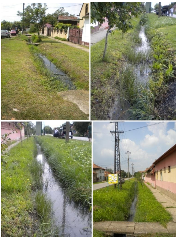
Slika 70. Opređeljeni kanali u Novom Bečeju (Izvor: Kavran, 2015)
