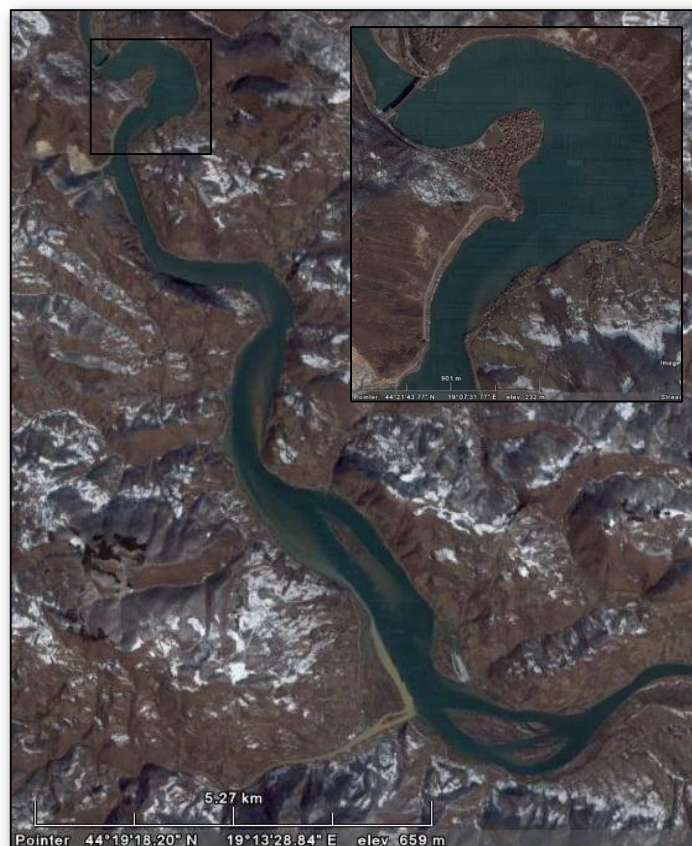
Slika 6.35 Situacija brane i akumulacije HE "Zvornik"
