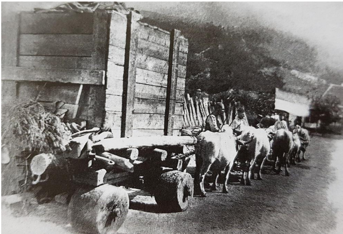
Слика 4.5. Транспорт турбине за ХЕ „Под градом“ 1899., фотографија. Репродуковано из Стефановић и Матић (2014, 509).
