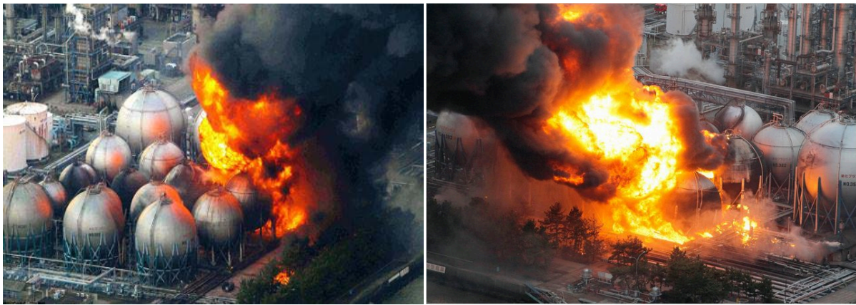
Slika 3.1. Požar procesne opreme izazvan zemljotresom u rafineriji nafte Ichihara, Japan
