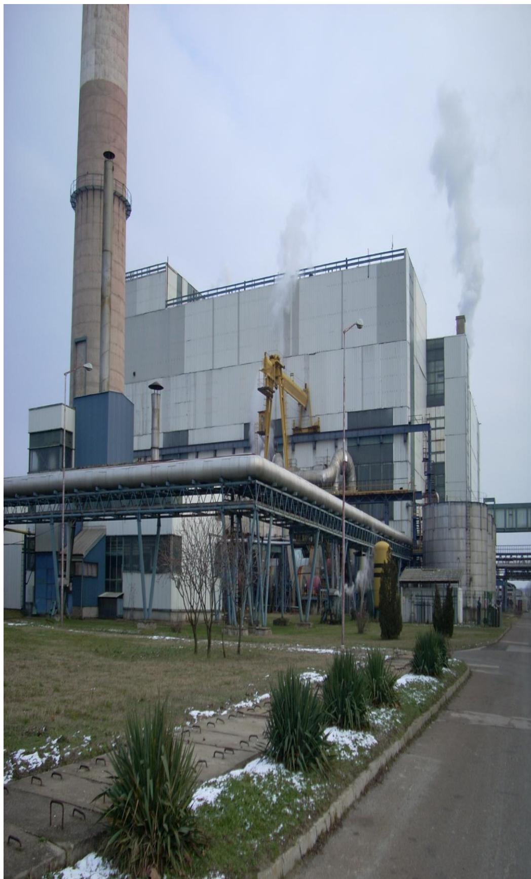
Слика 10.1.: Изглед Термоелектране-топлане Нови Сад (просторни изглед)
