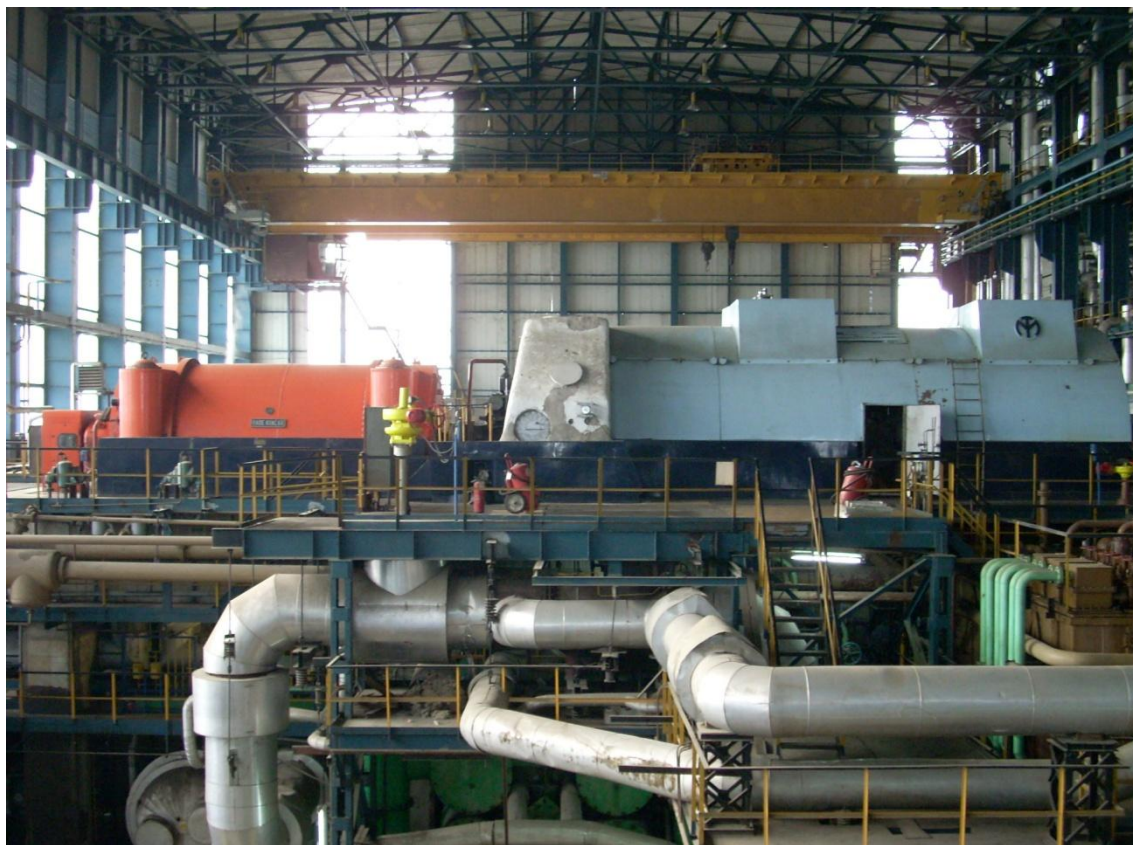
Слика 10.2.: Изглед парне турбине РТ-135 /165-130/15 у Термоелектрани-топлани „Нови Сад“
