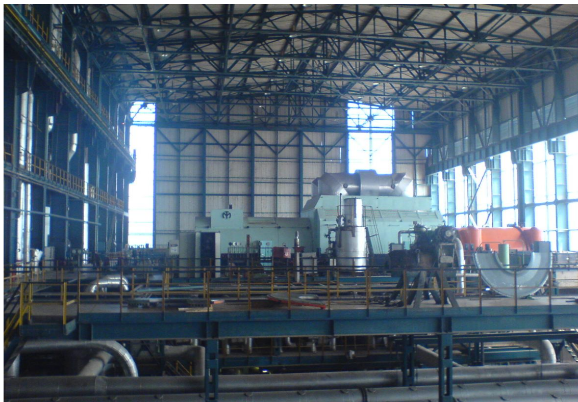
Слика 10.3.: Изглед парне турбине Т-110/120-130-4 у Термоелектрани-топлани „Нови Сад“ (просторни изглед)
