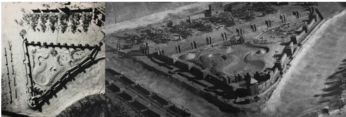
Слика 26: Пројекат реконструкције Смедеревске тврђаве, А. Ђокић и С. Личина, 1960. (Извор: документација из бироа „Романтична архитектура“.)
