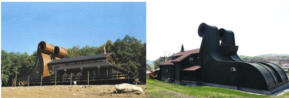
Слика 200: Кућа југословенско–норвешког пријатељства у Горњем Милановцу, А. Ђокић и В. Кујунџић, 1981–1987. (Извори: документација из бироа „Романтична архитектура“ (лево); фотографија аутора рада, 2013. (десно).)
