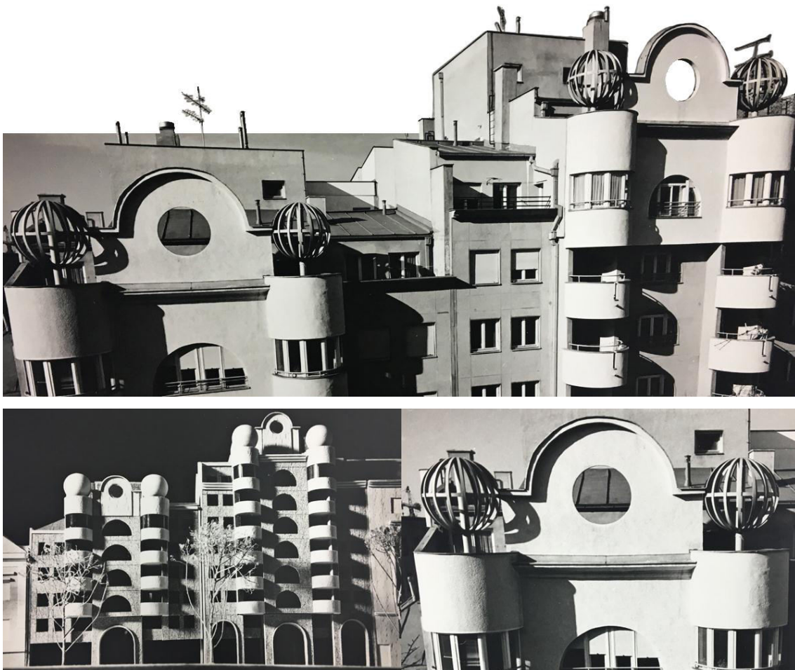
Слика 208: Стамбено–пословна зграда у ул. Краља Милутина бр. 46–48 у Београду – модел (доле лево) и изгледи (остало), А. Ђокић, 1984–1988. (Извор: документација из бироа „Романтична архитектура“.)
