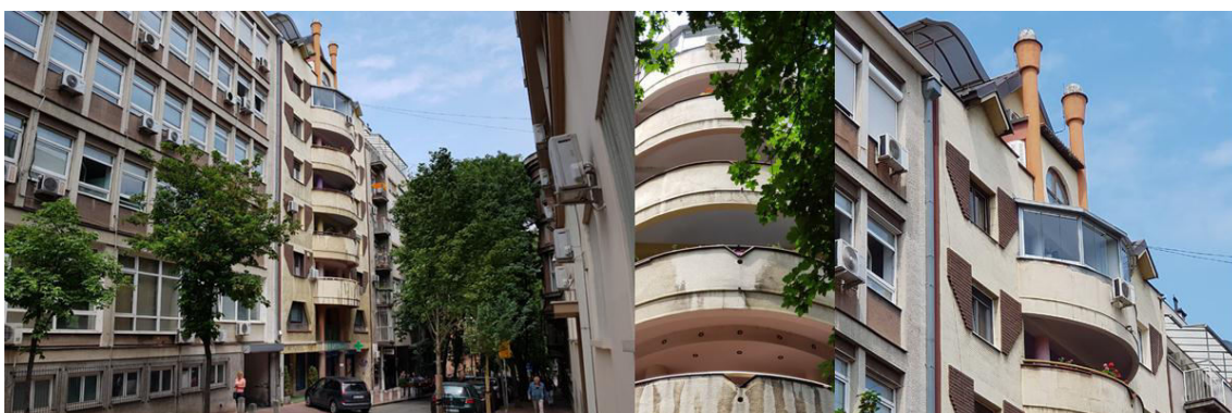
Слика 260: Изглед и детаљи фасаде стамбено–пословне зграде у ул. Доситејевој бр. 11, А. Ђокић, 1985–1990. (Извор: приватна колекција аутора рада, фото. Маријана Симић, 2018.)
