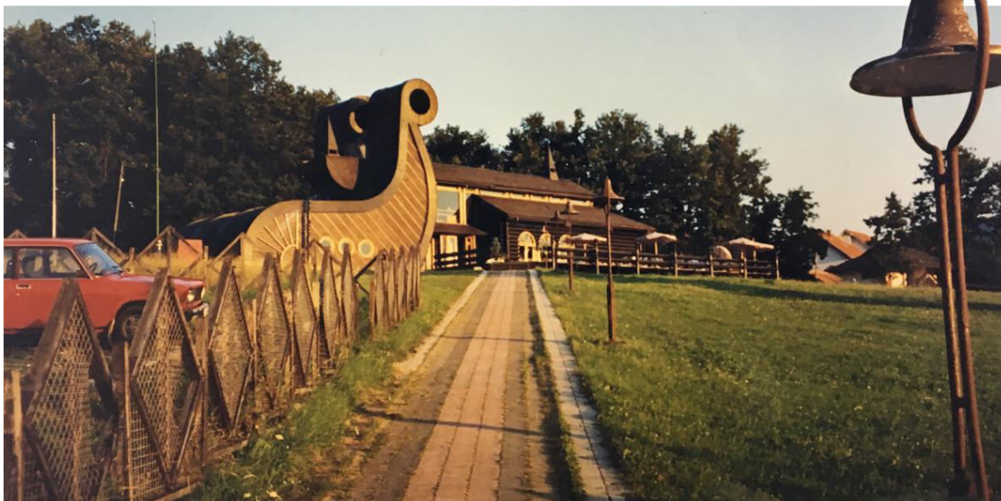
Слика 199: Кућа југословенско–норвешког пријатељства у Горњем Милановцу, А. Ђокић и В. Кујунџић, 1981–1987. (Извор: документација из бироа „Романтична архитектура“.)
