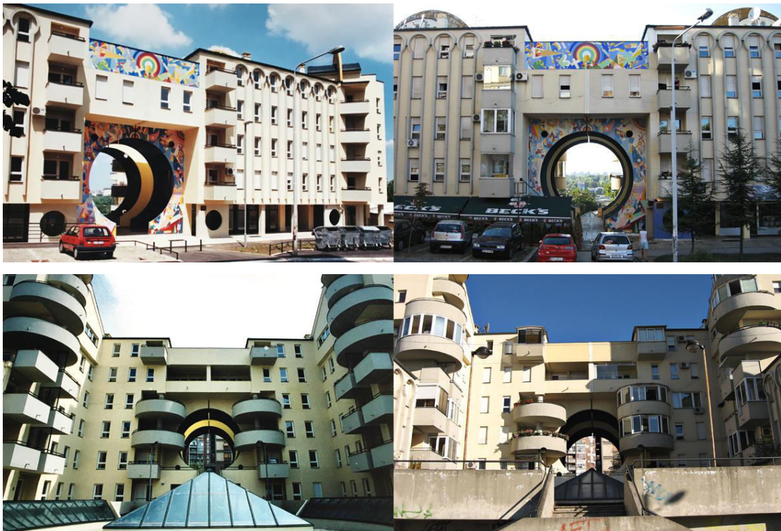
Слика 411: Стамбено–пословни комплекс „Објектив“ – поглед из Љешке некад (горе лево) и сад (горе десно) и поглед из Карпошеве некад (доле лево) и сад (доле десно), А. Ђокић, 1998–2001. (Извор: документација из бироа „Романтична архитектура“ (лева страна); фотографија аутора рада, 2011. (десна страна).)
