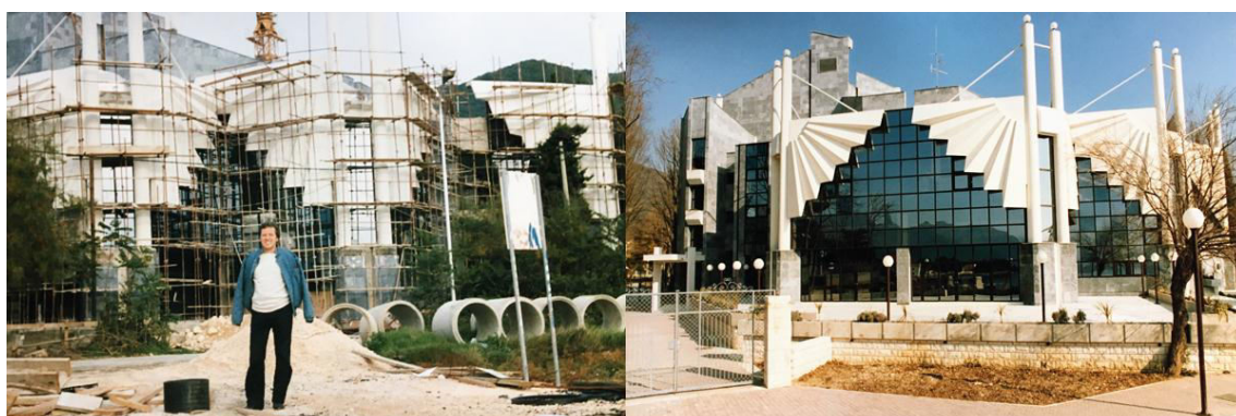
Слика 254: Александар Ђокић на градилишту у време изградње објекта (лево) и изглед (десно) Клуба Југословенске народне армије у Тивту, А. Ђокић и Б. Ђунисијевић, 1985–1989. (Извор: приватна заоставштина архитекте која се чува у бироу „Романтична архитектура“.)
