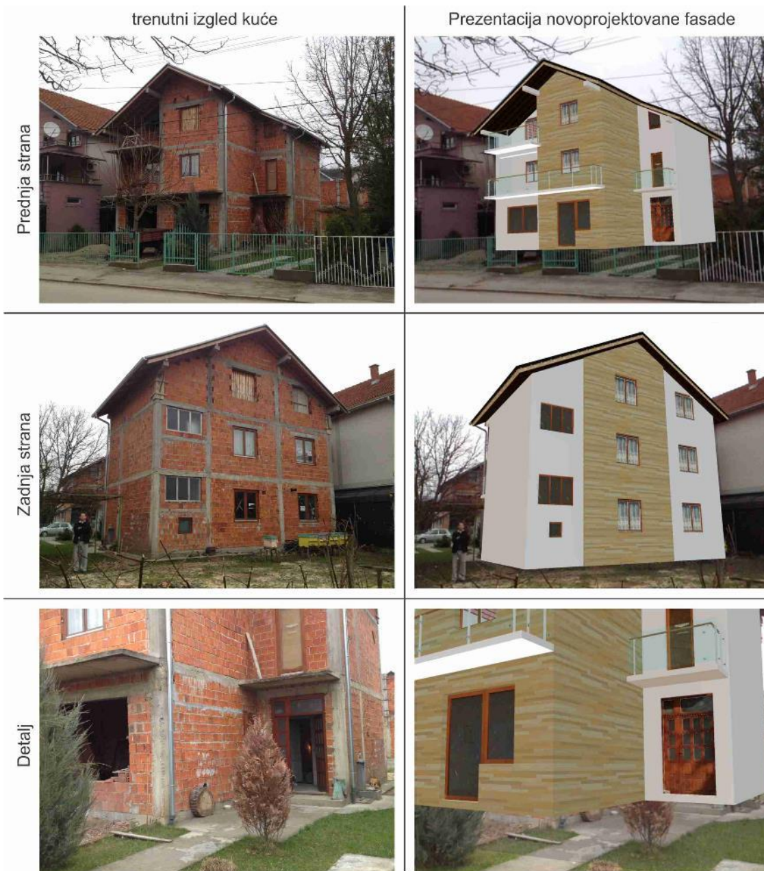
Slika 38: Uporedni prikaz postojećeg objekta i prezentacije novoprojektovane fasade metodom proširene stvarnosti (Pejić, et al., 2015).
