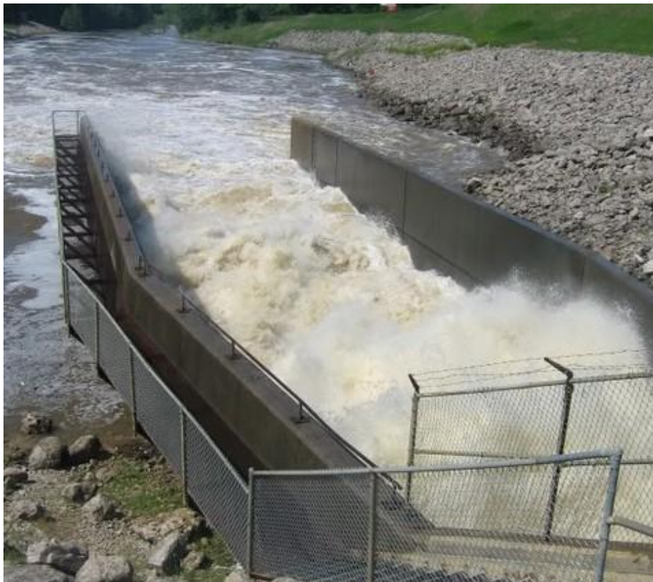
Слика 2.3 Хидраулички скок у умирујућем базену бране „Елк сити“, фотографија је преузета са интернет адресе:
