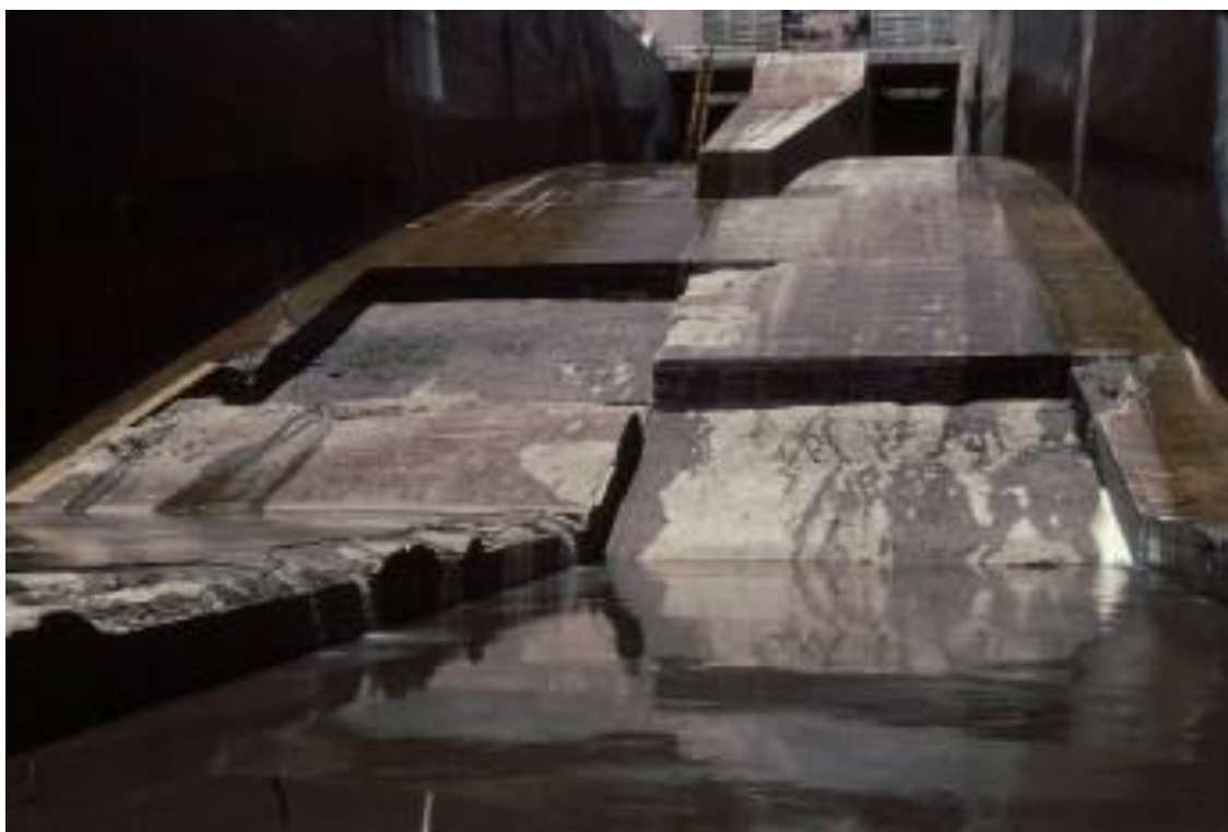
Слика 2.4 Оштећења од динамичког узгона на брани „Тарбела“ у Пакистану, фотографија је преузета са интернет адресе: http://phoenix-hodge.com/tarbela.php
