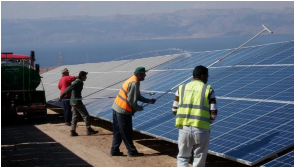
Slika 2.2. Manuelno čišćenje solarnih modula
