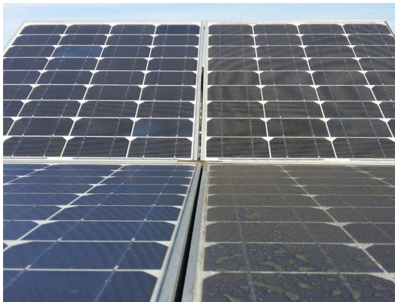
Slika 3.129. Horizontalni solarni modul (desno) zaprljan nataloženom čađi nakon slabe i kratkotrajne kiše
