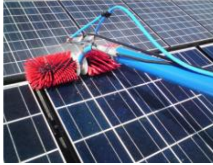
Slika 2.3. Čišćenje solarnih modula vodom pod pritiskom i četkom
