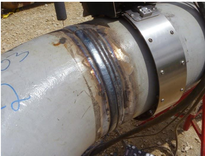
Слика 4.11 Проблеми са квалитетом заварених спојева услед неодговарајућих прелаза, непоклапања и пракси у заваривању цеви великог пречника [68]
