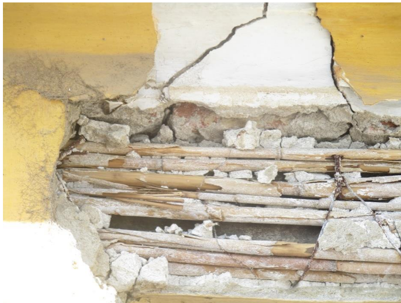
Детаљ старог плафона са трском и малтером
