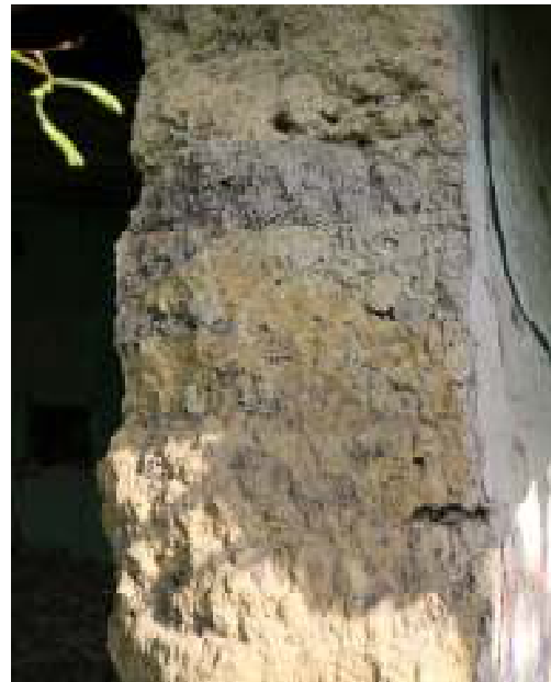
Слика 7.4: Зид од набоја у пресеку, напуштена кућа у Иванову
