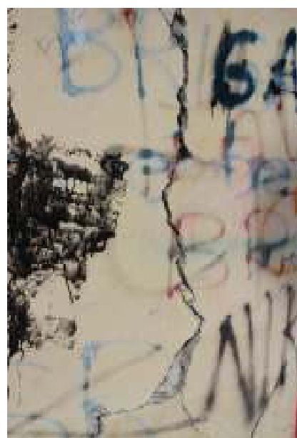
Слика 9.3: Пукотина на спољашњем делу зида од набоја
