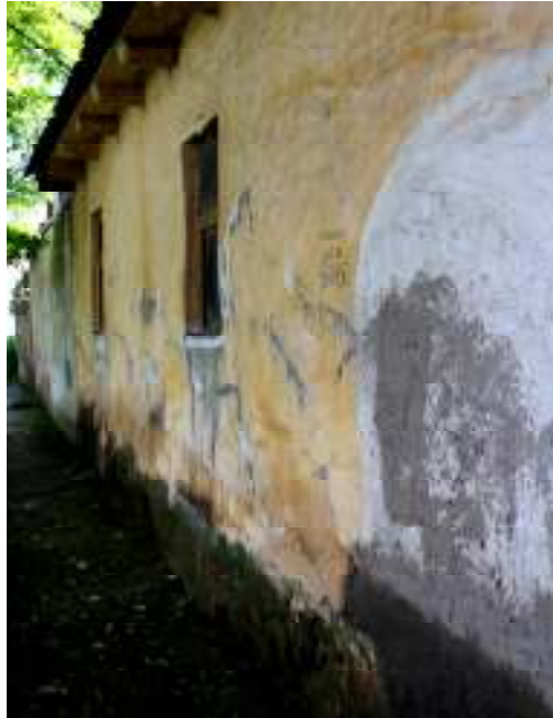
Слика 9.1: Влага у доњем делу зида код куће од набоја
