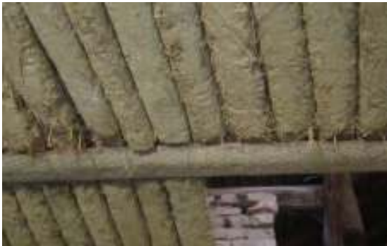
Слика 3.34: Међуспратна конструкција у процесу реконструкције, викле
