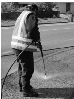
Слика 2.28 Одржавање порозног бетона са водом под притиском [8]
