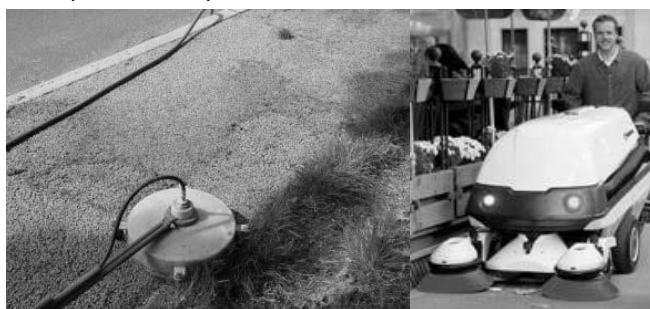
Слика 2.30 Одржавање порозног бетонског коловоза са вакуумским чишћењем [8]
