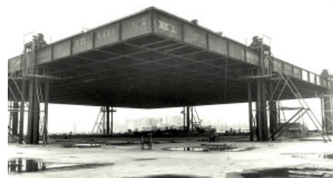
Slika 244. Mis van der Roe, Nacionalna galerija, Berlin 1962-68, maksimalna dematerijalizacija vertikalnih elemenata i geometrizacija konstrukcije i fleksibilnog prostora.
