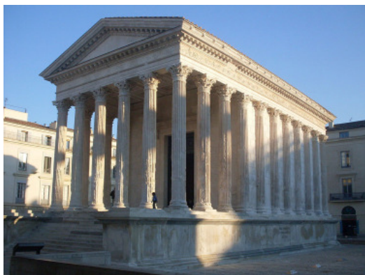
Slika 207. Maison Carrée (2 n.e.), Nim, Francuska
