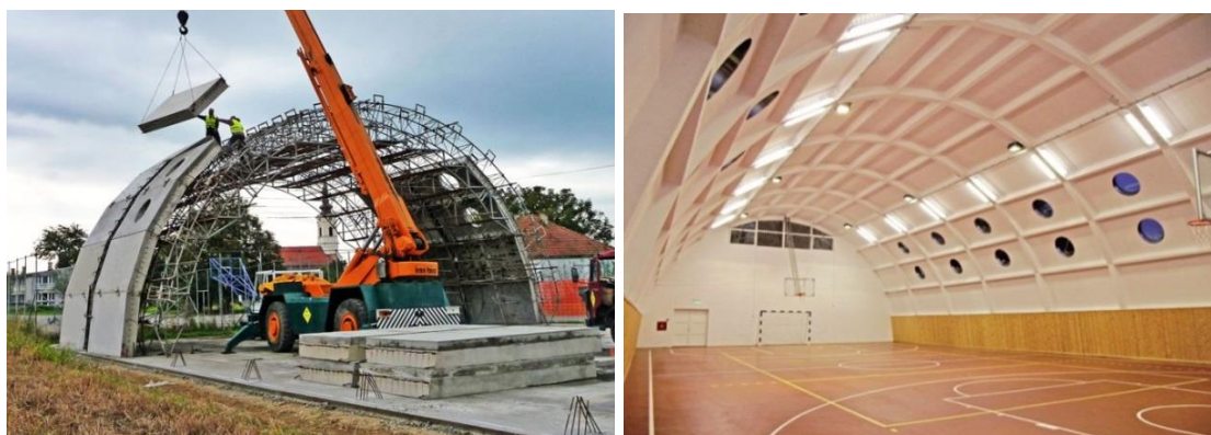
Слика 120. Грађење хале у МС систему градње. [Преузето са http://www.milinkovicco.com/preuzimanje_fajlova/slike/hale/izgradnja/7.jpg , 4.11.2012.]
