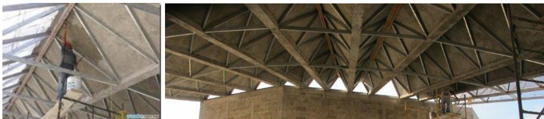
Слика 122. Наборана кровна конструкција формирана као композитни склоп. [Преузето са http://yucatan.com.mx/multimedia/valladolid-se-une-en-un-sueno-2-galeri , 8.11.2012.]
