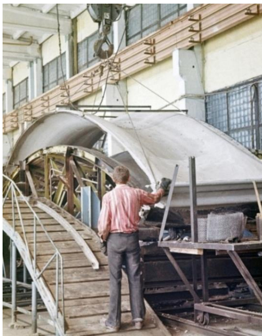
Слика 78. Механизована производња фероцементних љуски, СССР. [Преузето са http://3.bp.blogspot.com/_REW5h1F5sv8/TN0QM7eacFI/AAAAAAAAAKZE/I_qnlSgtS84/s1600/27.jpg , 2.10.2012.]
