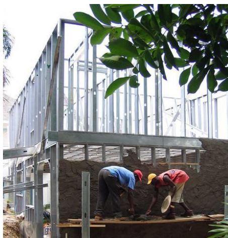
Слика 123. Објекат у Am-cor систему, у фази градње. [Преузето са http://www.am-cor.com/galleries/gallery/construction/ , 16.11.2012.]
