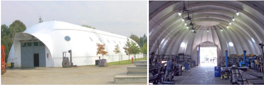
Слика 102. Милинковић, Складишна хала, Бољевци, 1999., фасада. [Преузето са http://www.milinkovicco.com/preuzimanje_fajlova/slike/ostali_objekti/5.jpg , 15.7.2012.]
