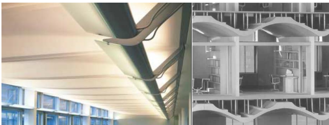
Слика 9. Унутрашњи елементи који рефлектују светлост на глатке површине засвођене бетонске таванице, у оквиру зграде Градског већа; Свордс, Ирска, 2000., архитектонско решење Бухолц МекЕвој архитекти. [Извор: Irish Energy Centre. Fingal county hall - low energy offices, Good Practice Case Study 9. ]
