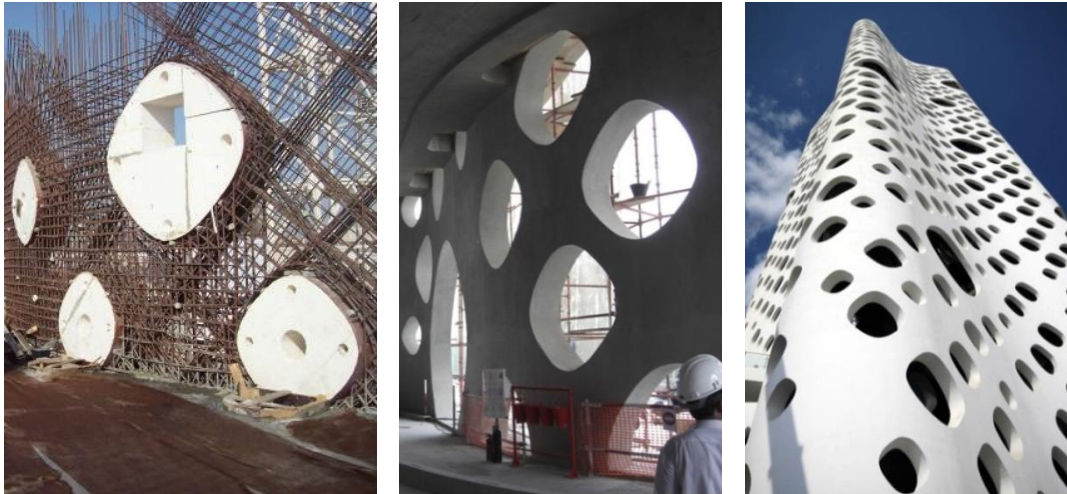
Слика 23. Рајсер+Умемото, О-14, Дубаи, Уједињени Арапски Емирати, 2010., изградња, носећи фасадни зид, фасада. [Преузето са http://www.morfae.com/0795-reiser-umemoto/ и http://www.archdaily.com/22200/in-progress-0-14-tower-by-reiser-umemoto/ , 19.3.2011.]
