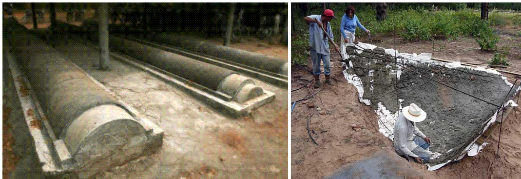
Слика 51. Извођење фероцемента применом отворене оплате од готових фероцементних елемената. [Преузето са http://www.atcdhaka.com/fero.html , 15.2.2012]
