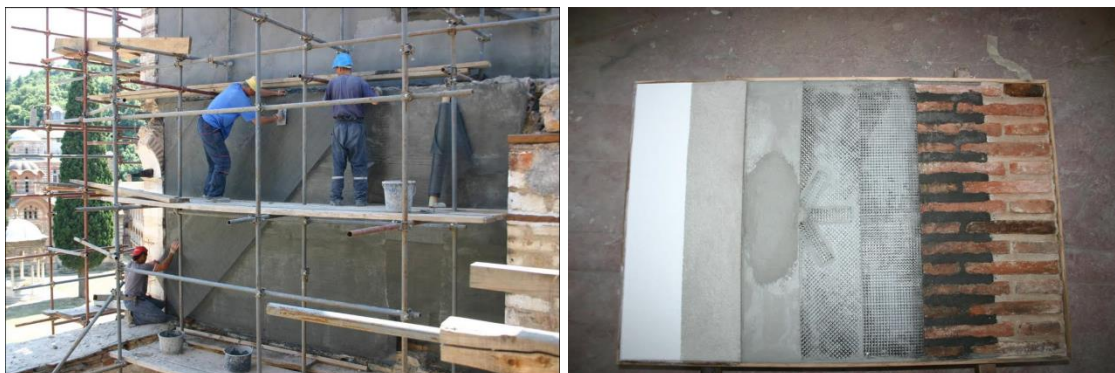
Слика 132. Објекат у оквиру манастира Хиландар, Света Гора, Грчка, извођење радова на ојачавању зидане конструкције применом слоја фероцемента, карактеристични слојеви ојачаног зида. [Извор: Фотографије из архиве аутора проф. др Ненада Шекуларца, пројектанта конструкција у оквиру пројекта обнове комплекса манастира Хиландар]
