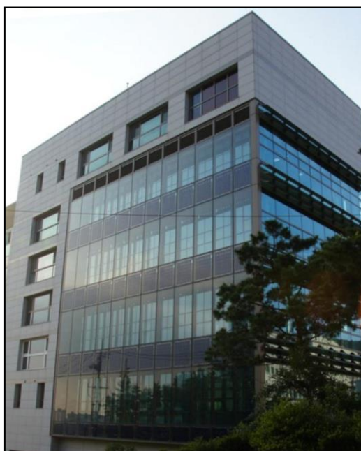
Slika 1.24: Tip fasade sa integrisanim solarnim panelima (objekat izgrađen u Južnoj Koreji)
