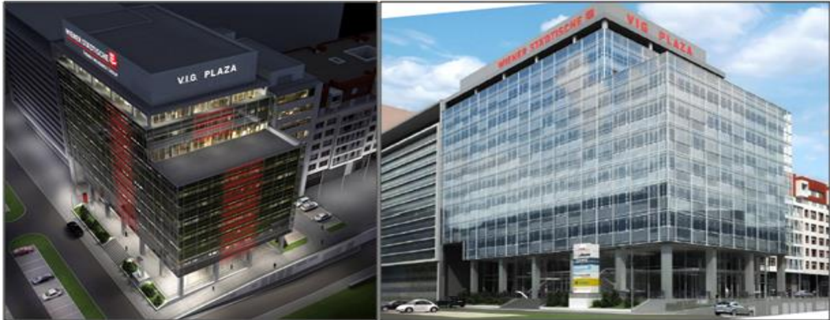
Slika 1.37: Poslovni objekat VIG Plaza (Izvor: projektna dokumentacija objekta)
