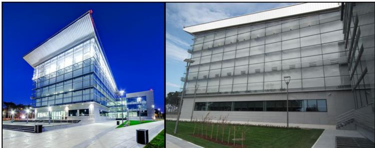
Slika 1.38: Zgrada Agencije za kontrolu letenja SCG (Izvor: projektna dokumentacija)
